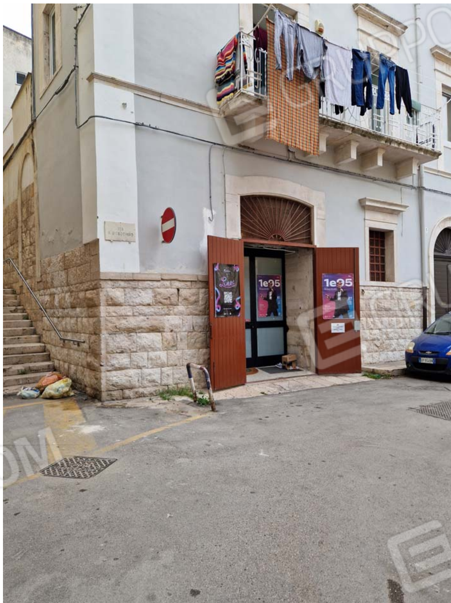
accesso all'immobile di via San Gioacchino
