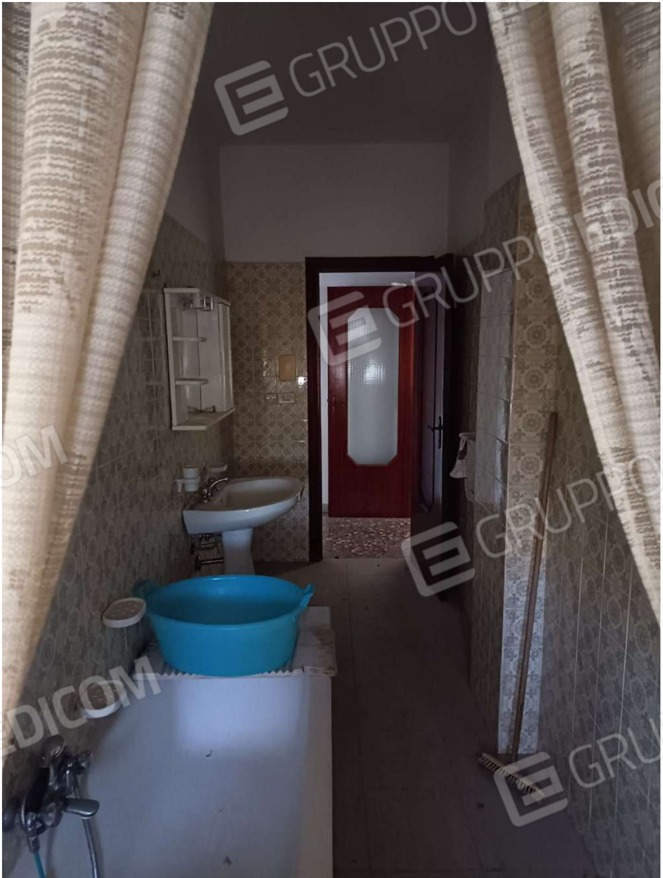
Foto n°20: Vista del bagno dell'appartamento oggetto di stima.
