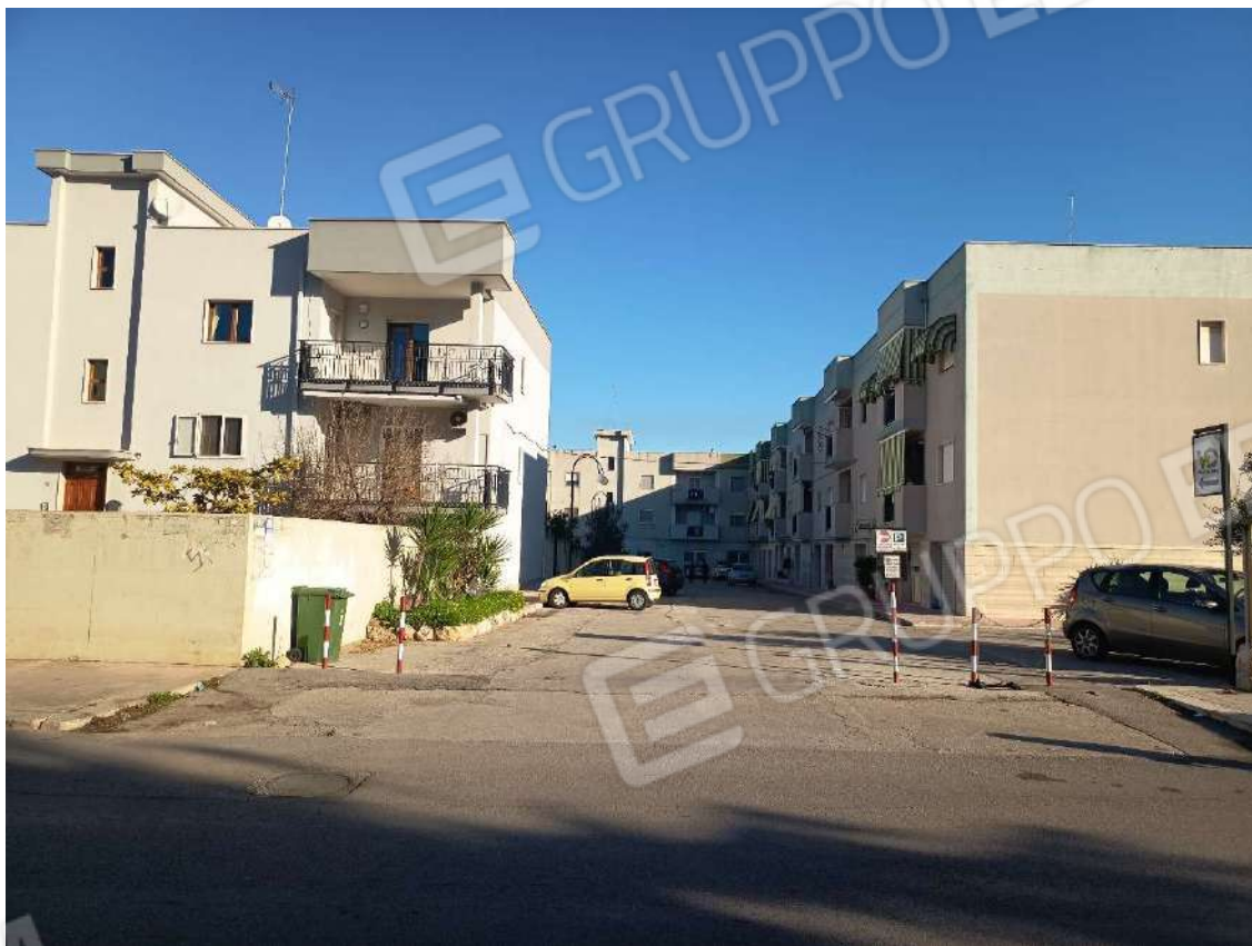
Foto n°1: Vista dell'ingresso al complesso immobiliare da Via Carrara Reddito.
