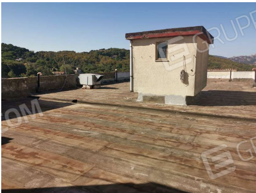
Foto 011 – Dettaglio copertura edificio
