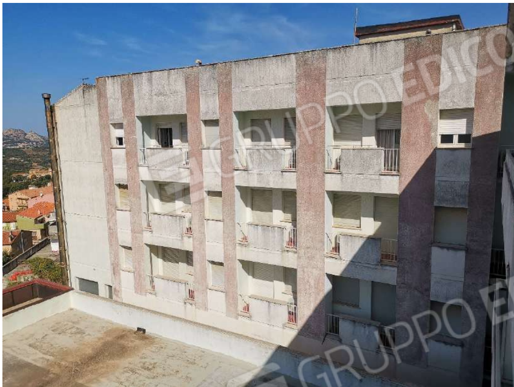
Foto 010 – Dettaglio facciata interna laterale
