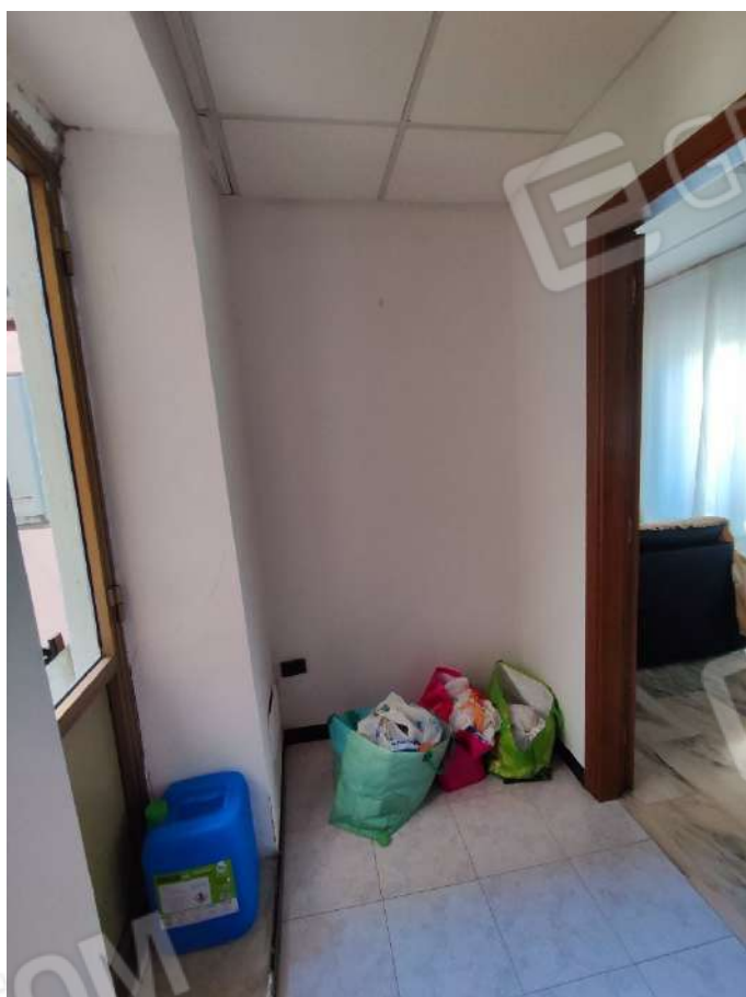
Foto 033 – Corridoio Appartamento alloggio Gestore Hotel
