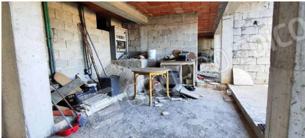
Foto 119 – Dettaglio locale adiacente scale esterne
