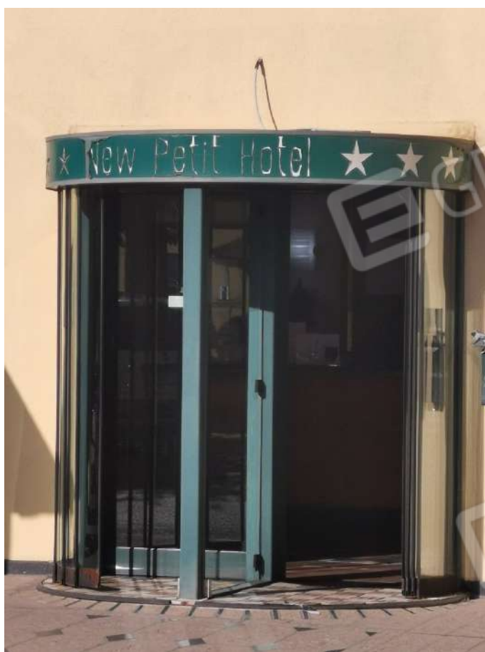
Foto 013 – Dettaglio Ingresso Principale
