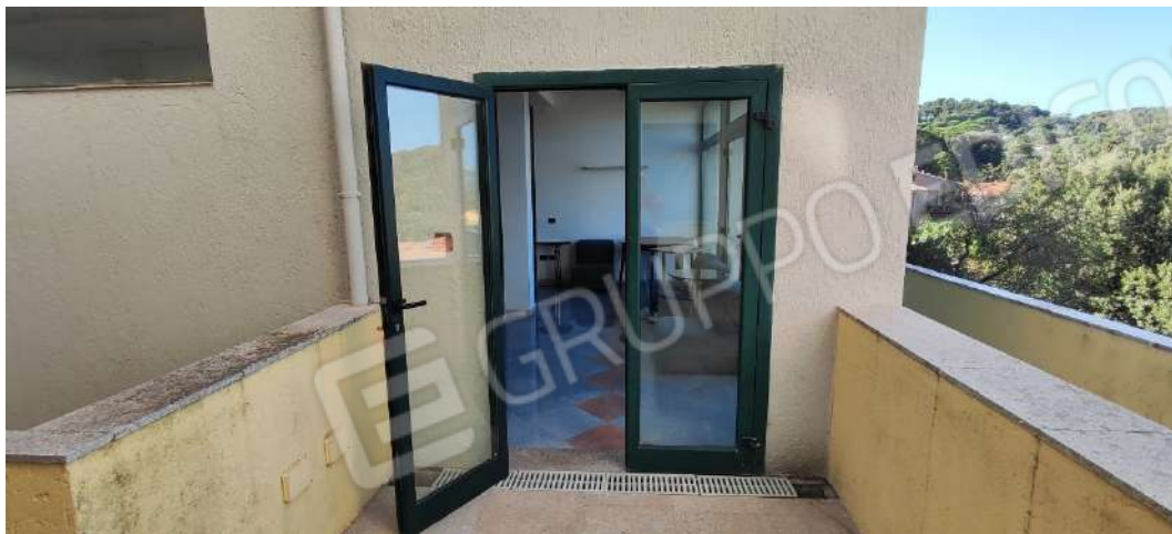
Foto 088 – Ingresso dall'esterno Sala Polivalente
