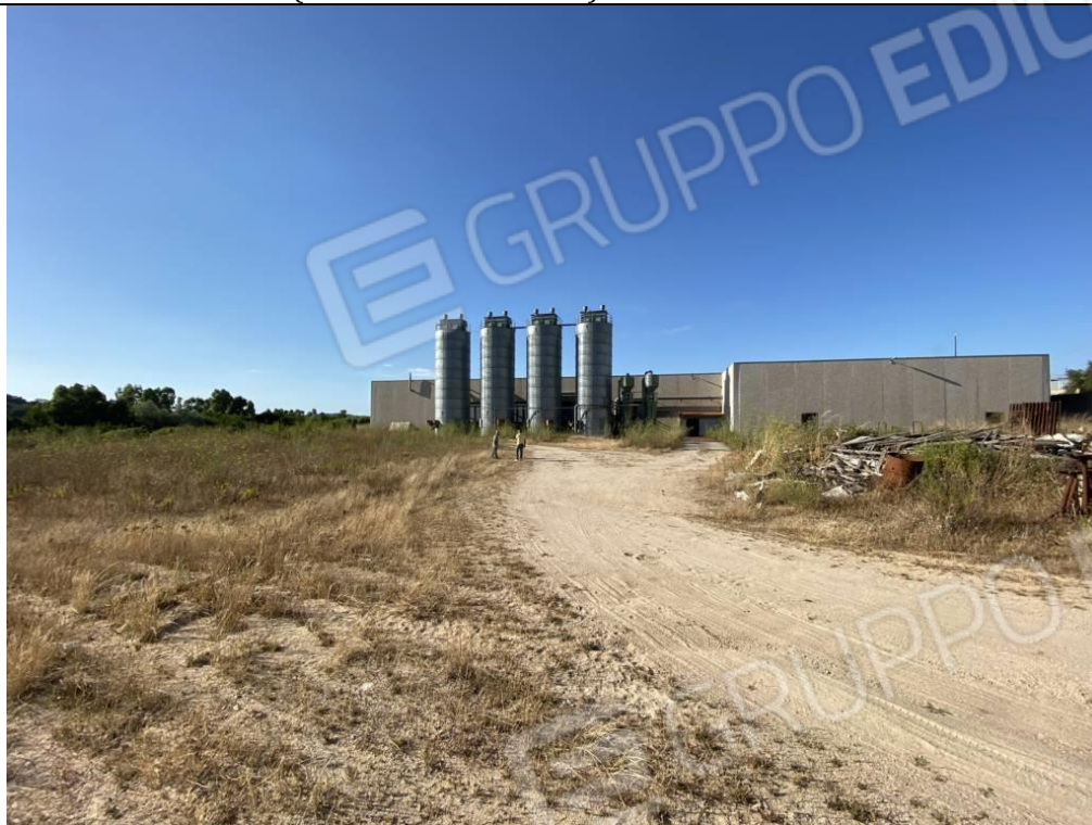
STRADA STERRATA INTERNA (vista da interno lotto)
