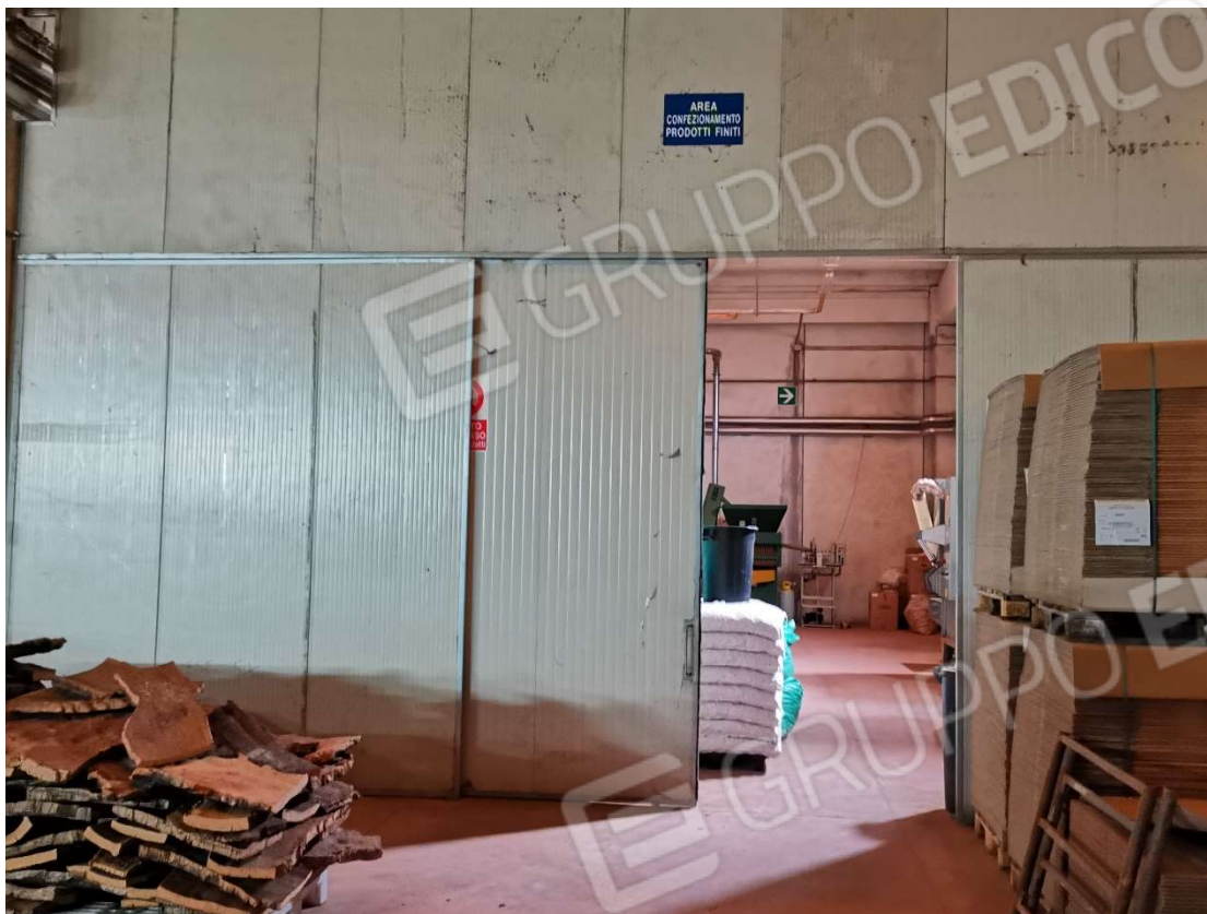
FOTO 030 – PIANO TERRA, SALA LAVORAZIONE 2
