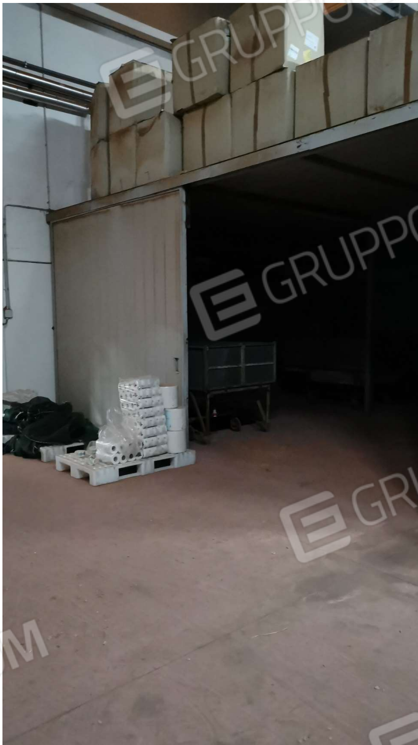
FOTO 027 – PIANO TERRA, ESSICCATOIO
