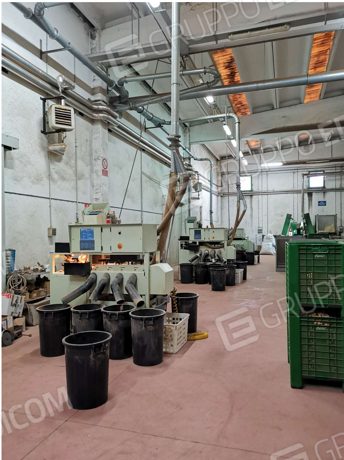
FOTO 019 – PIANO TERRA, SALA LAVORAZIONE 1
