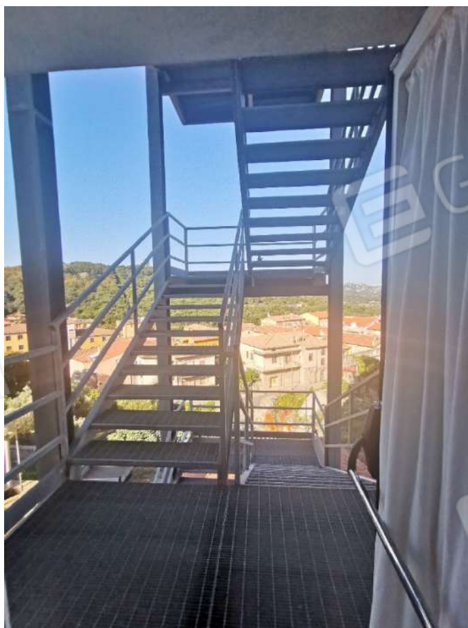
Foto 002 – Dettaglio scale di collegamento esterne
