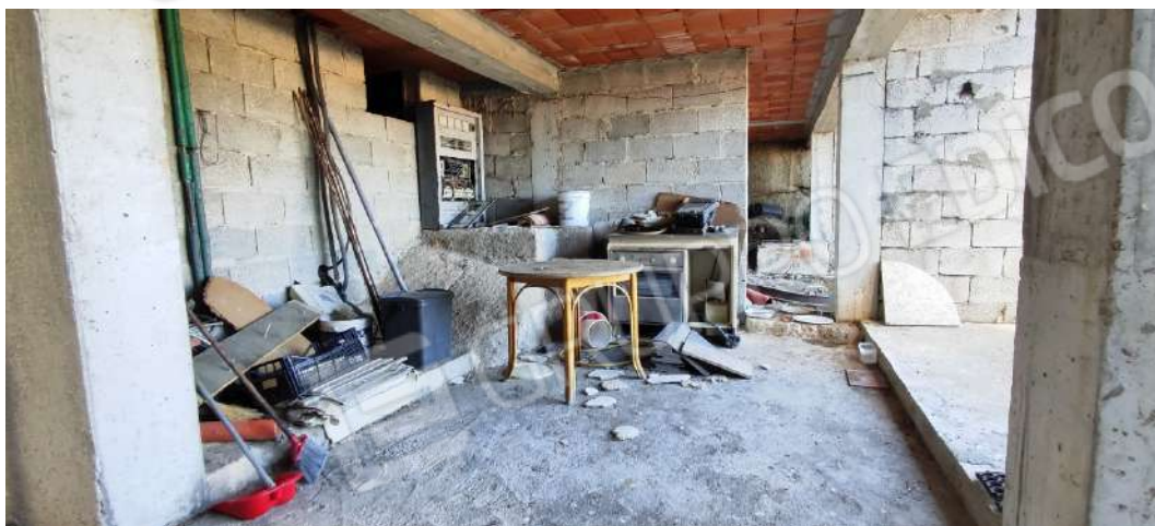
Foto 119 – Dettaglio locale adiacente scale esterne
