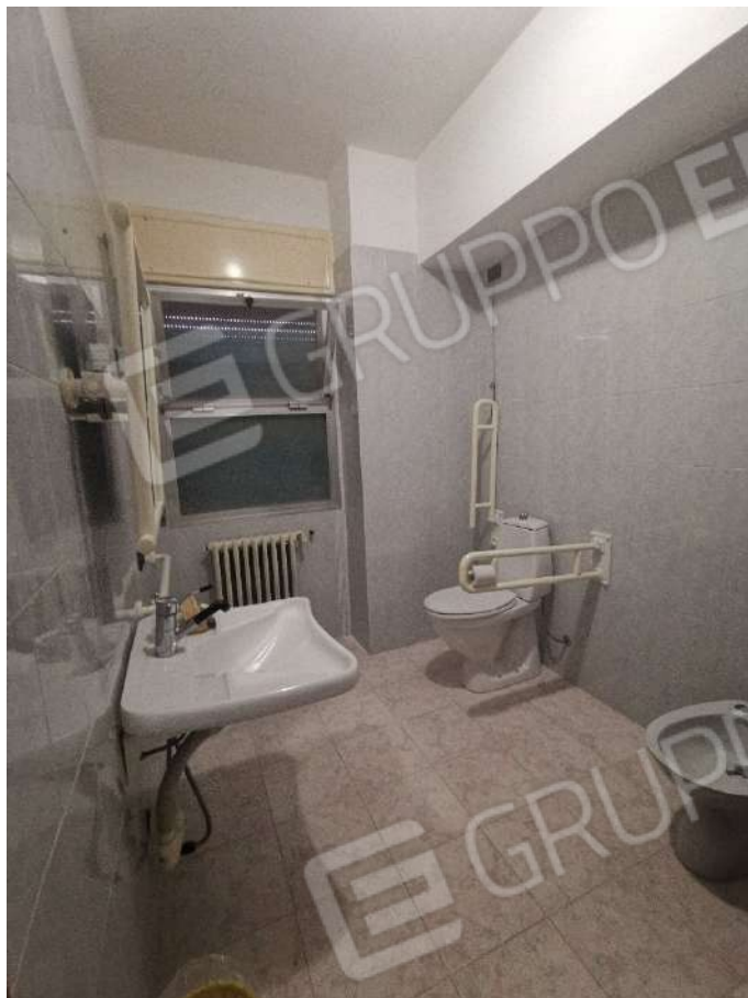
Foto 095 – Bagno Camera per Disabili n° 405
