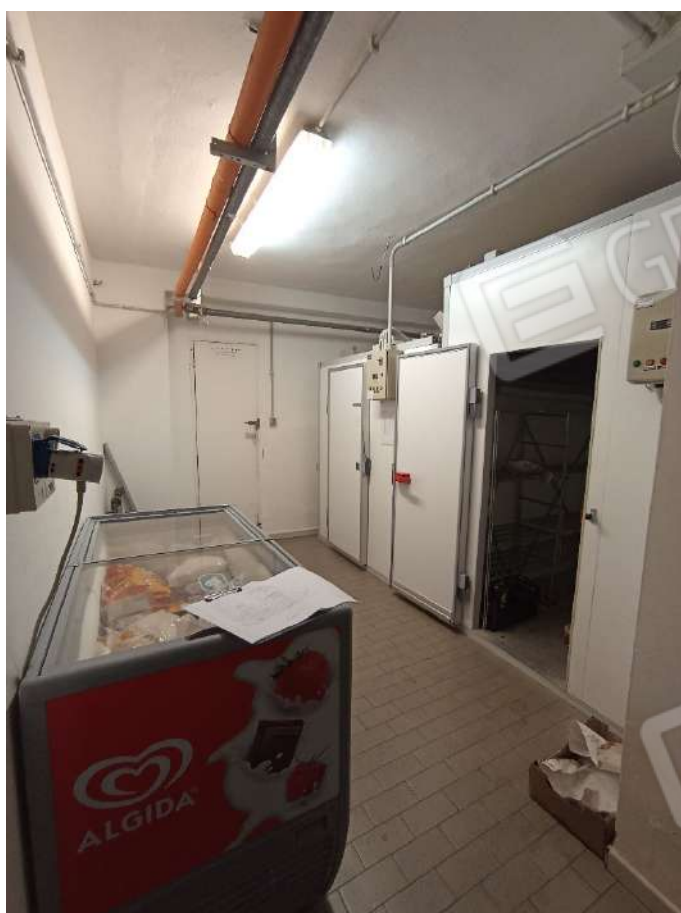
Foto 104 – Zona Celle Frigo
