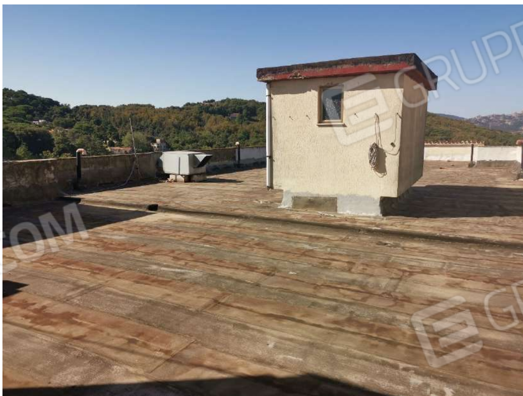
Foto 011 – Dettaglio copertura edificio
