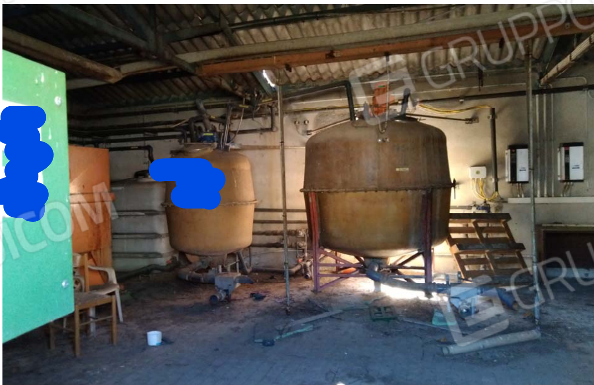
87 – LOCALE PREPARAZIONE MANGIMI – Interno – (Particella 169)
