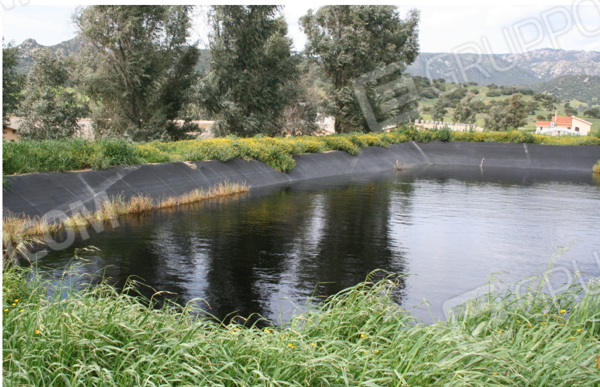
113 – LAGUNE DI OSSIDAZIONE: Vista interna di una vasca
