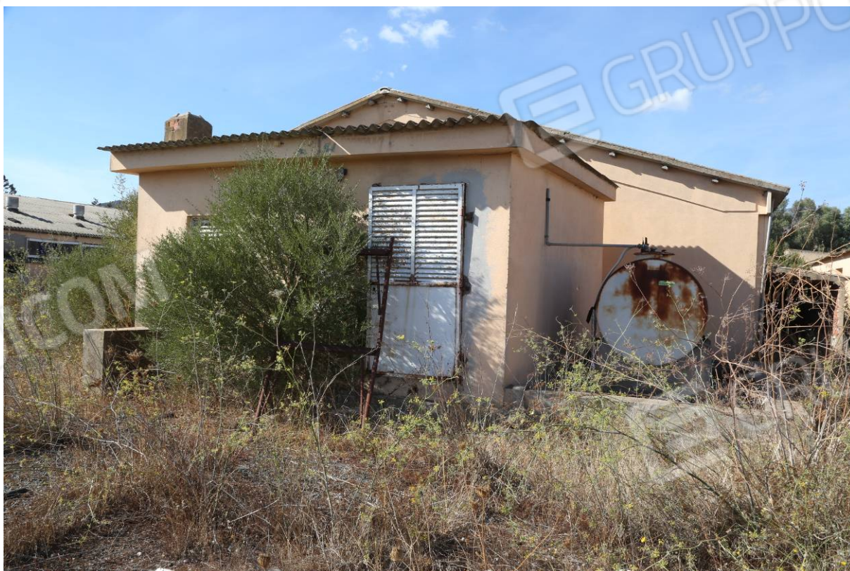
89 – CENTRALE TERMICA 1 (Particella 199)
