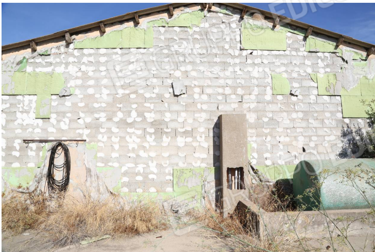
67 – BOX SVEZZAMENTO – (Particella 154) Fronte ovest
