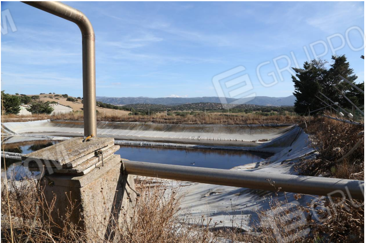
111 – IMPIANTO BIO GAS: Vasca
