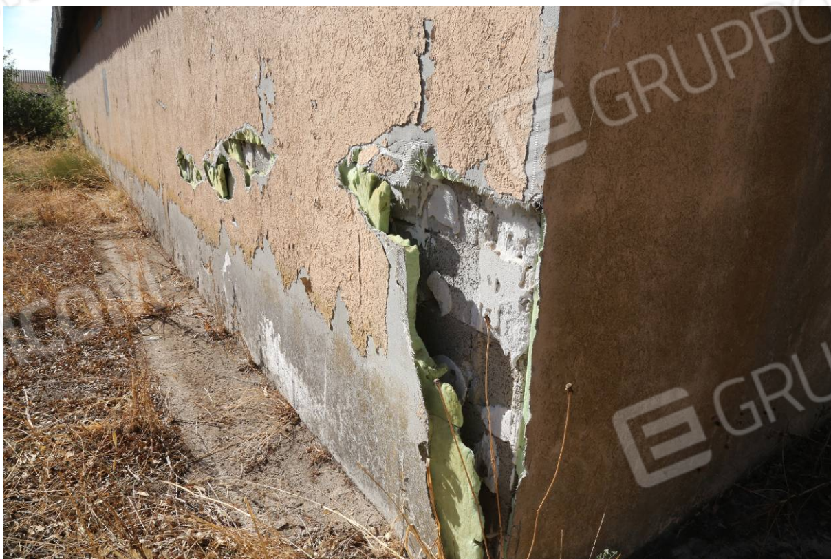
68 – BOX SVEZZAMENTO – (Particella 154) Fronte sud
