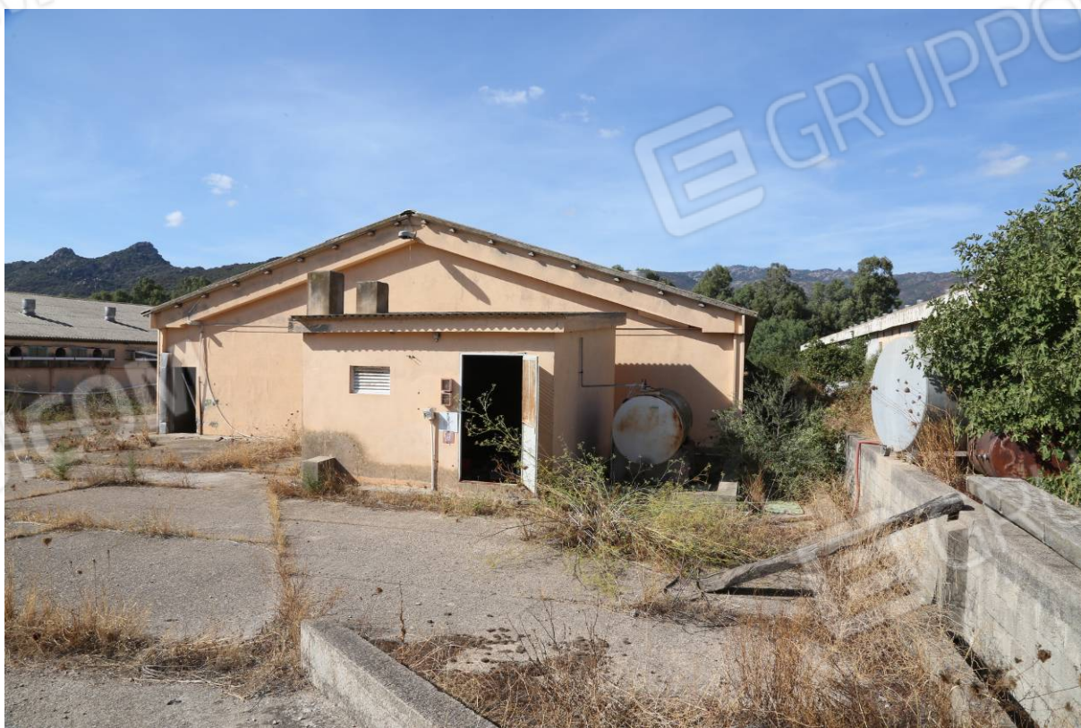
91 – CENTRALE TERMICA 2 (Particella 200)
