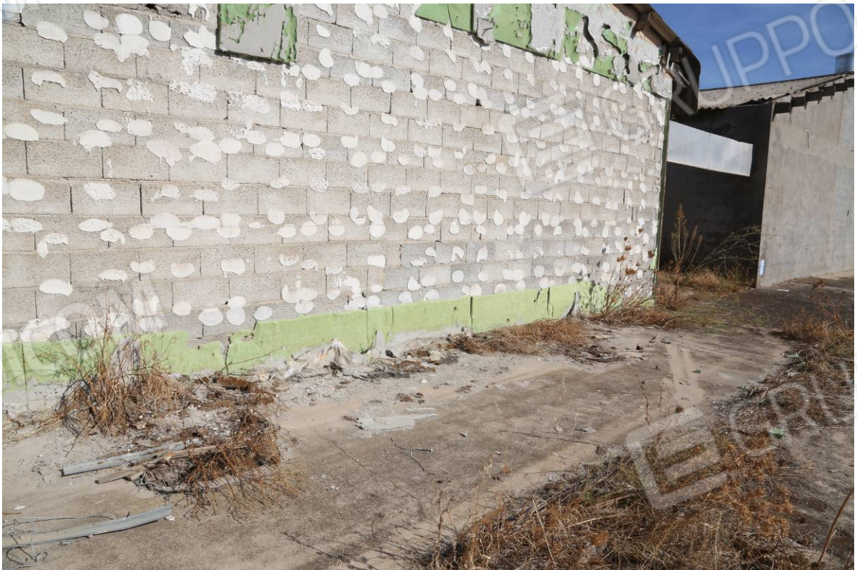
71 – BOX SVEZZAMENTO – (Particella 155) Fronte ovest
