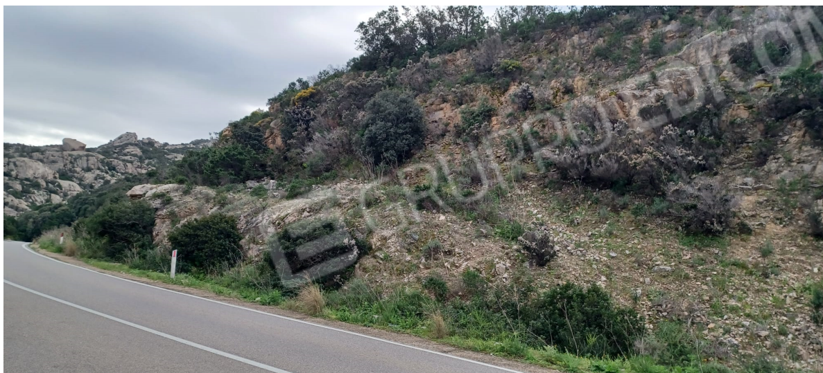
Foto n° 1 – Vista terreno lato Nord SP 59
