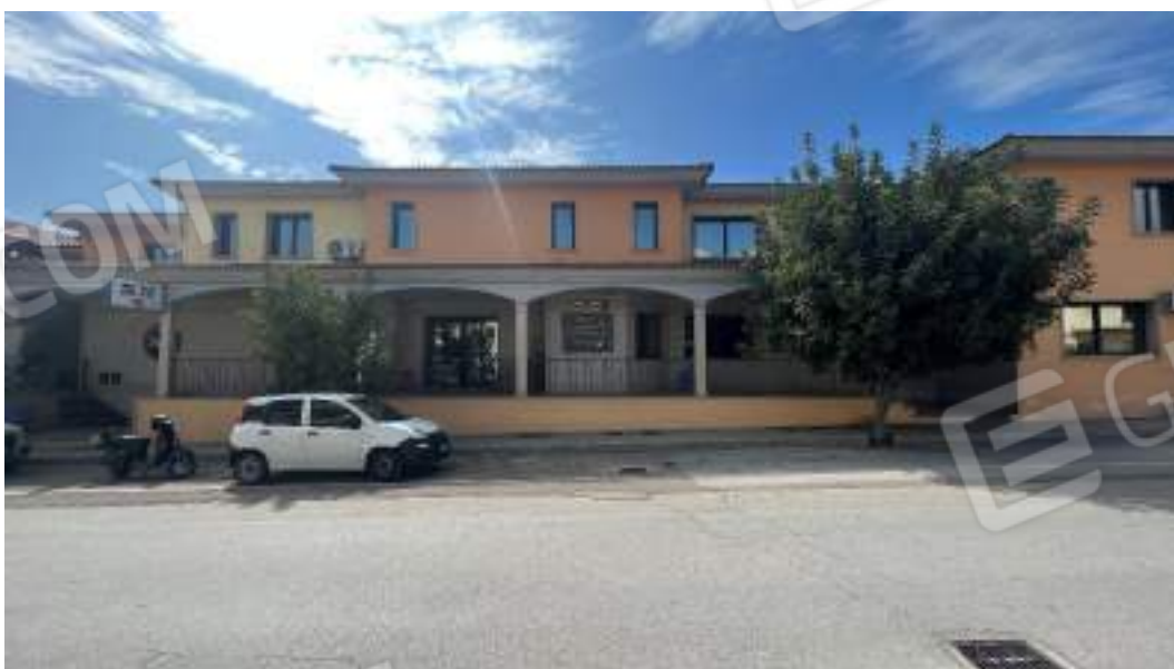
Figura 1 – Viste delle facciate fronte strada del fabbricato
