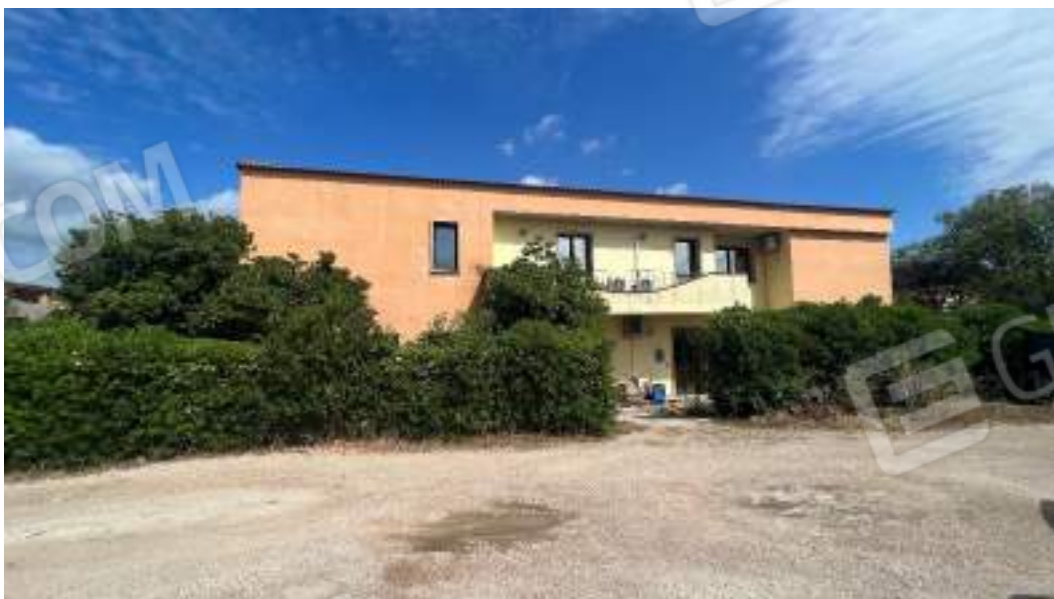
Figura 4 – Viste delle facciate fronte strada del fabbricato
