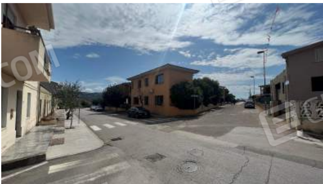
Figura 2 – Viste delle facciate fronte strada del fabbricato
