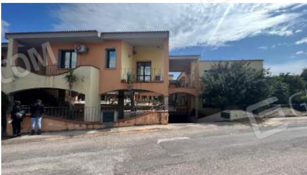
Figura 3 – Viste delle facciate fronte strada del fabbricato
