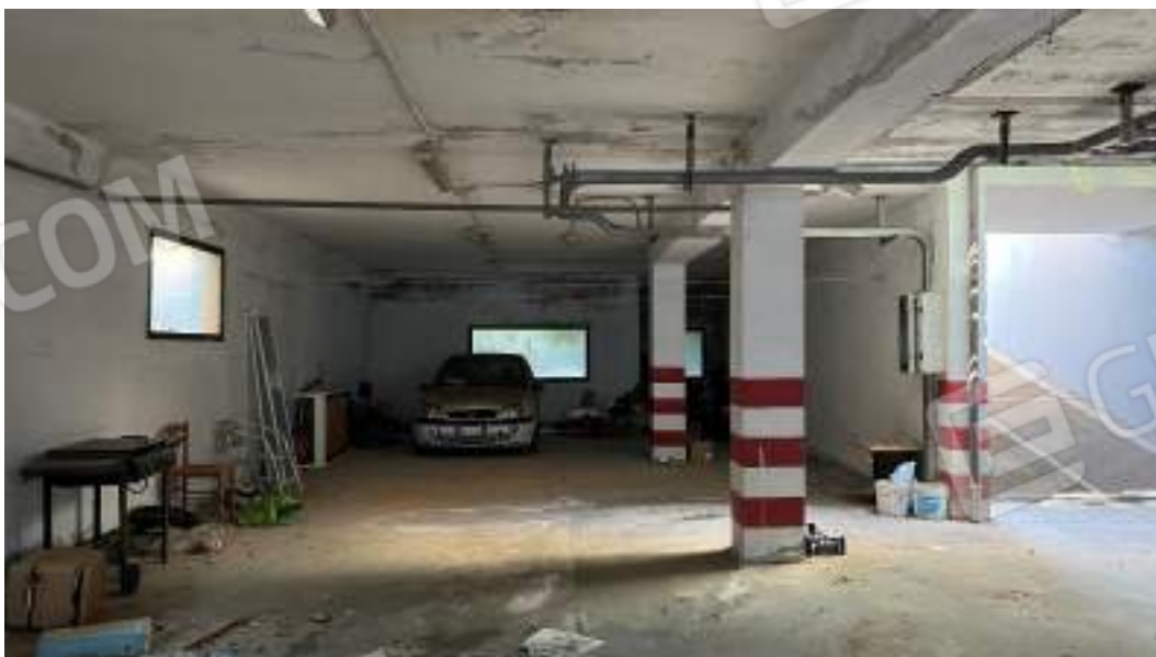
Figura 11 – Viste interne del fabbricato – piano interrato
