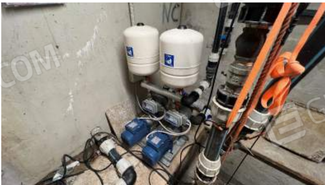
Figura 8 – Viste interne del fabbricato – piano interrato
