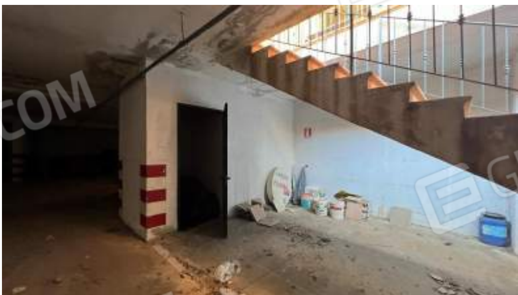
Figura 16 – Viste interne del fabbricato – piano interrato
