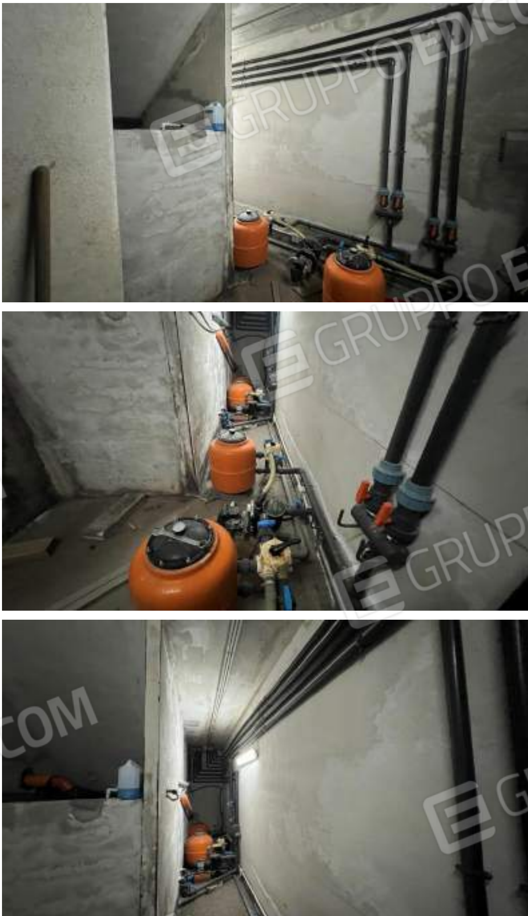
Figura 13 – Viste interne del fabbricato – piano interrato
