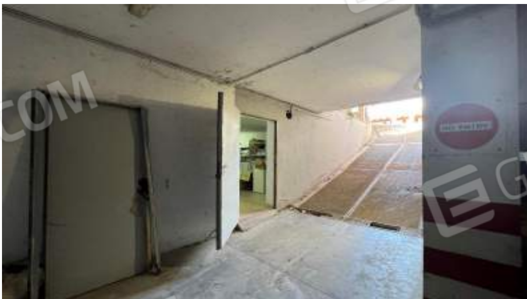
Figura 9 – Viste interne del fabbricato – piano interrato
