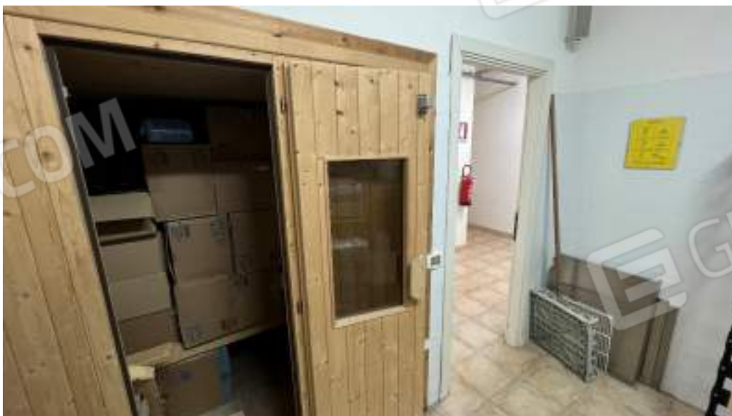
Figura 6 – Viste interne del fabbricato – piano interrato
