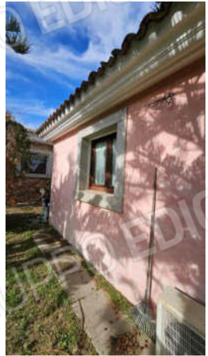
Vista prospetto su Via Cesare Balbo
