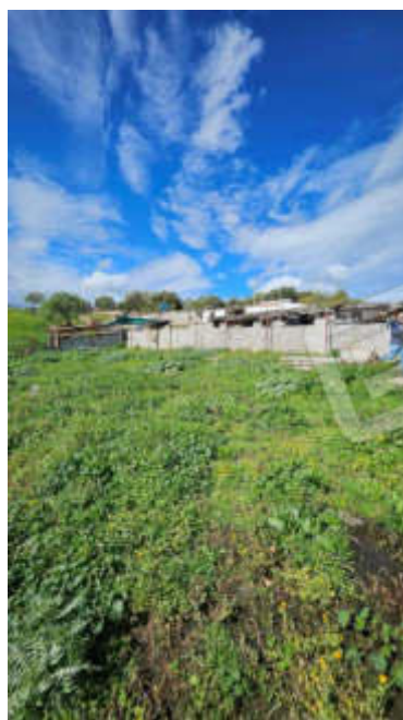
Vista mappale 564 e struttura precaria
