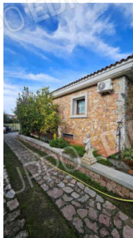
Vista prospetto su viottolo ingresso
