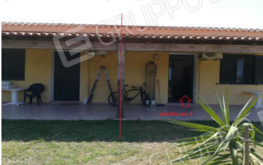
1) Vista prospetto Ovest
