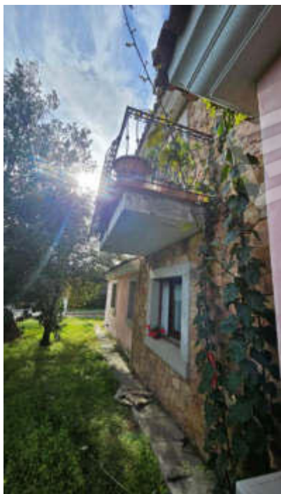
Vista prospetto su Via Cesare Balbo
