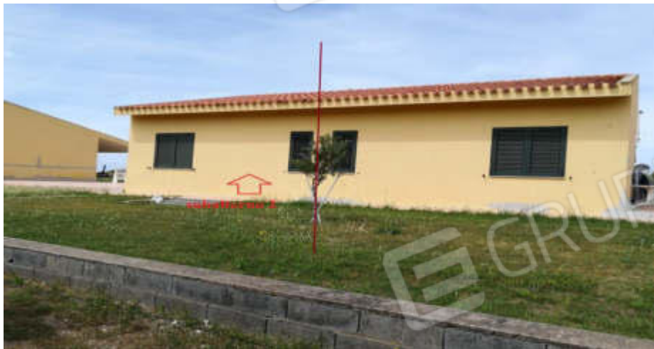
2) Vista prospetto est
