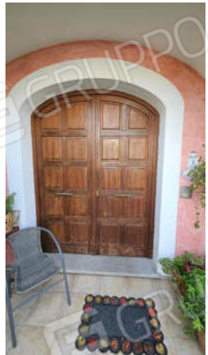
Vista prospetto ingresso
