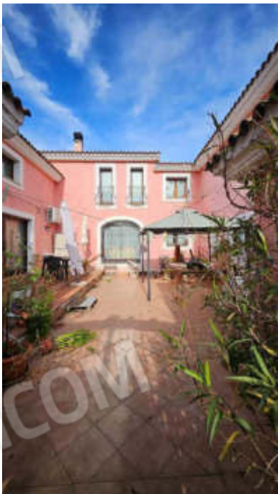
Vista prospetto su cortile interno
