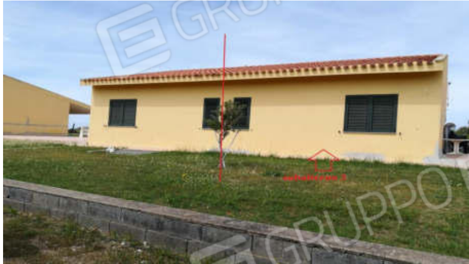
1) Vista prospetto est
