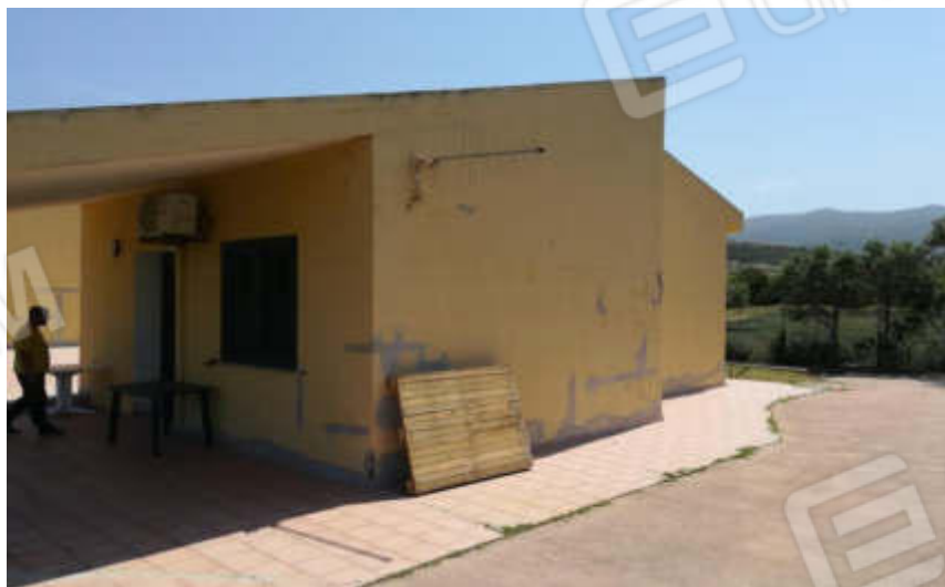
2) Vista prospetto Sud
