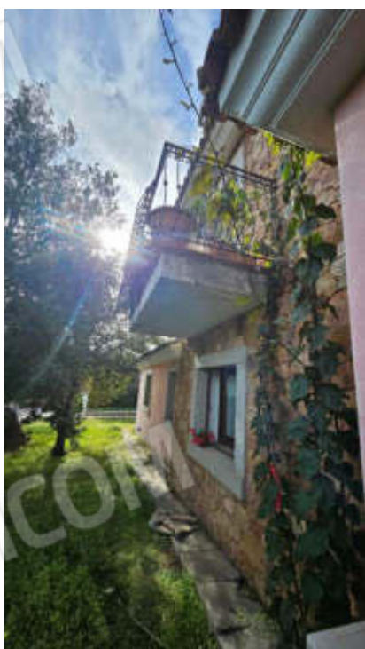
Vista prospetto su cortile
