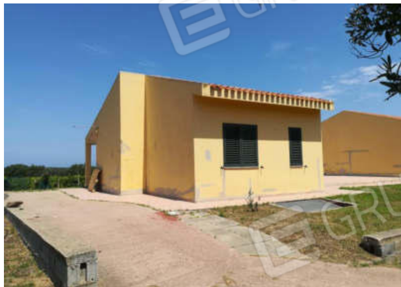
4) Vista prospetto Est
