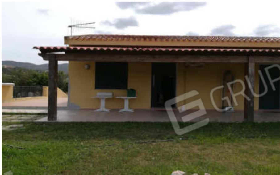
3) Vista prospetto ovest
