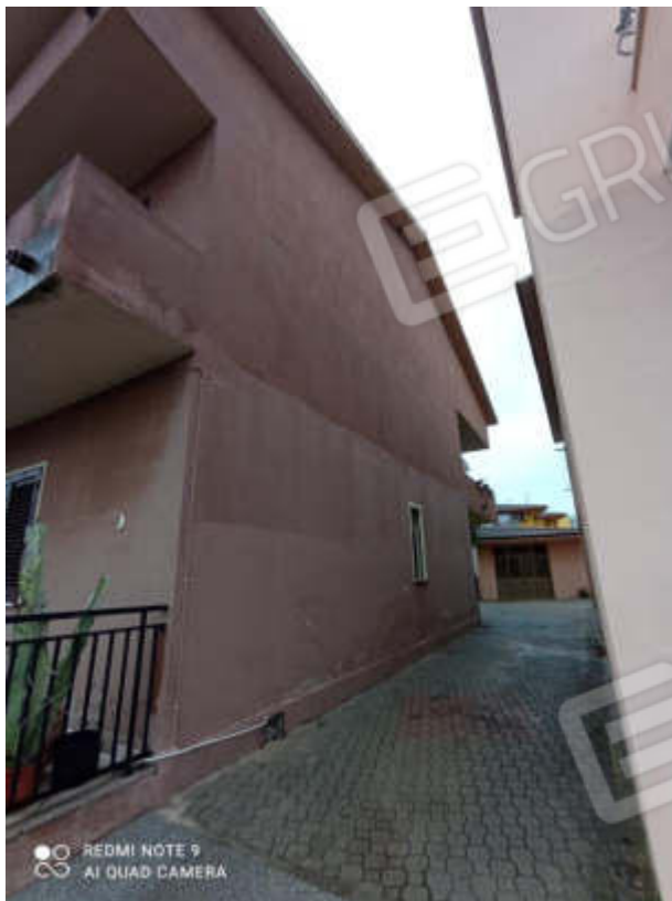
Prospetto su Viottolo Interno
