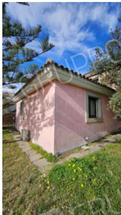
Vista prospetto su Via Cesare Balbo
