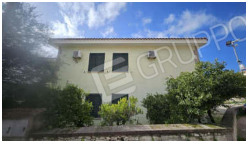
Prospetto laterale vista da via La Muddizza
