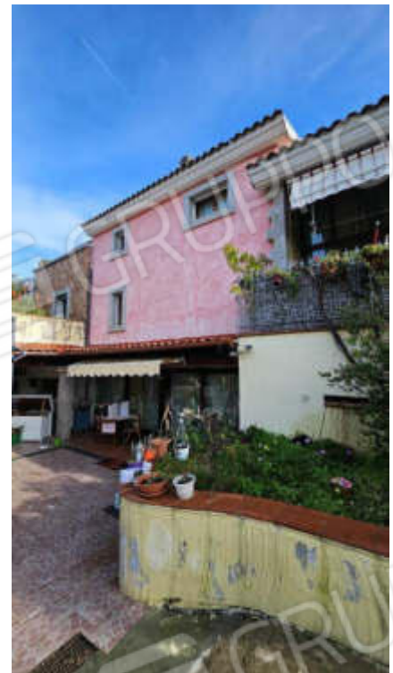
Vista prospetto su cortile
