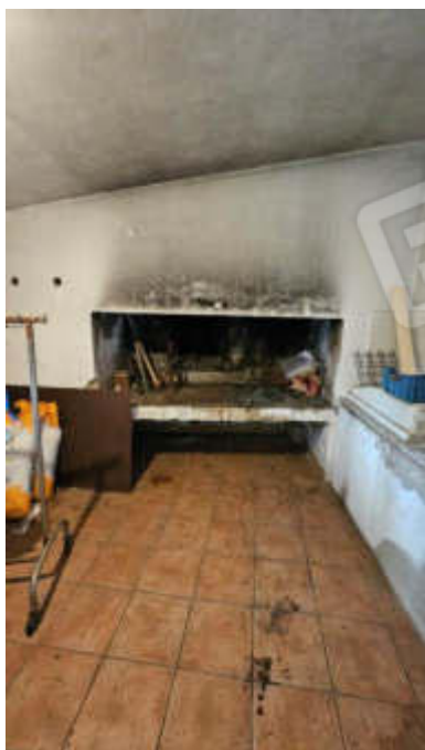
Sgombero (ingresso da tettoia )
