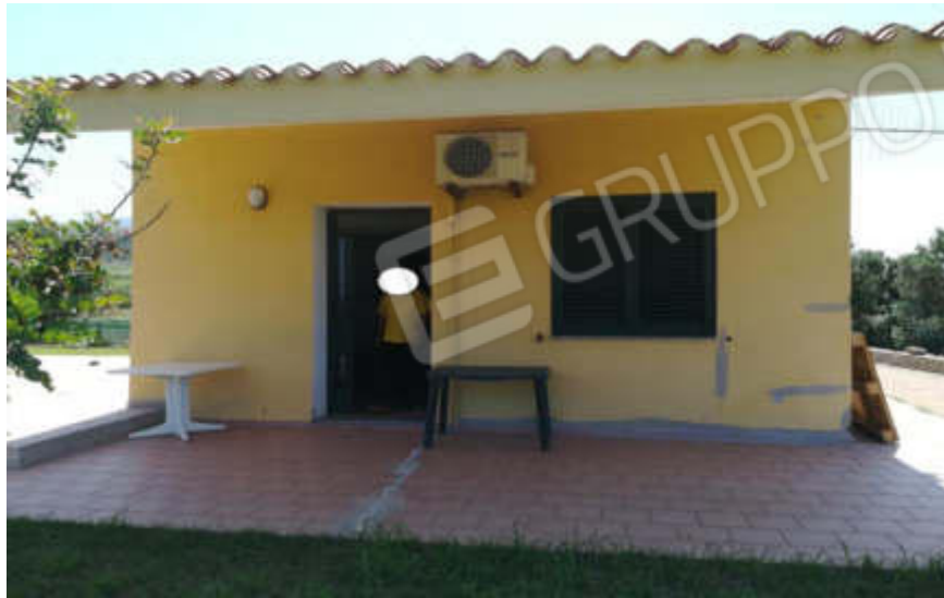
1) Vista prospetto Ovest
