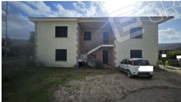
Prospetto principale Vista da Via La Muddizza
