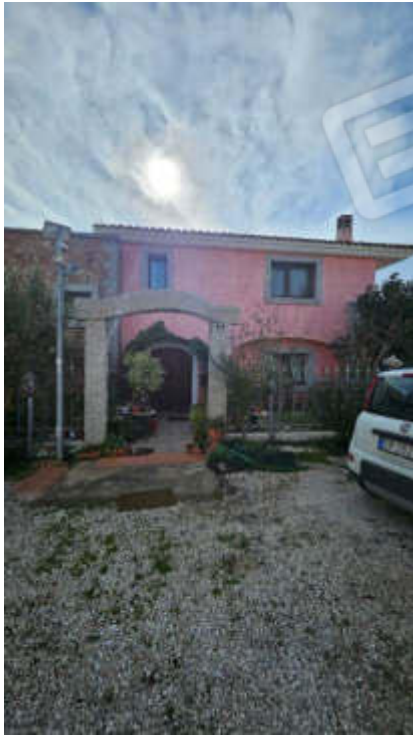
Vista prospetto ingresso
