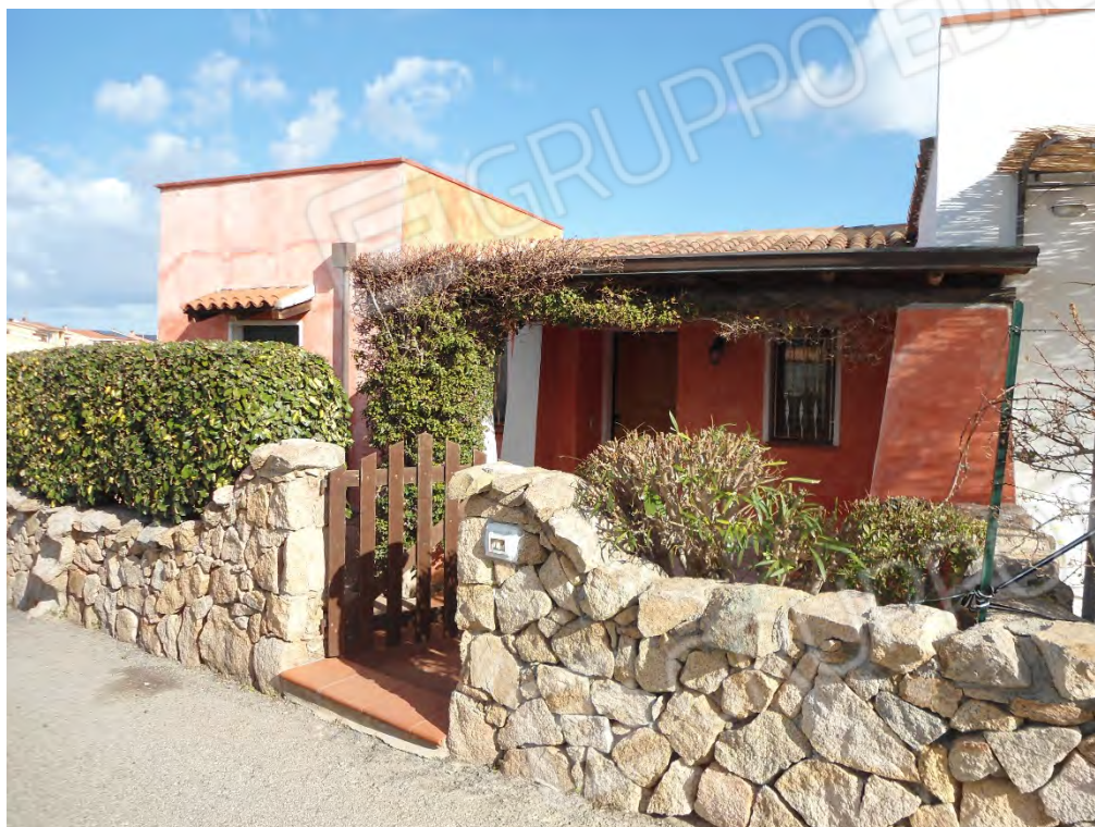
Foto n.3 – Ingresso all'immobile dalla strada carrabile di lottizzazione
