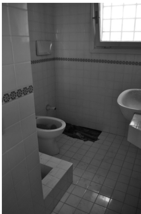
figg. n.18-19-20. Bagno con dettaglio del wc dismesso e rottura massetto e rivestimento
