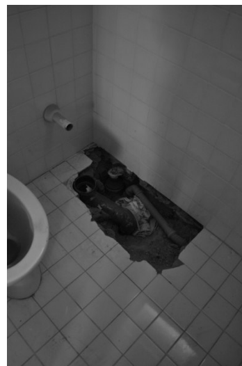
figg. n.18-19-20. Bagno con dettaglio del wc dismesso e rottura massetto e rivestimento
