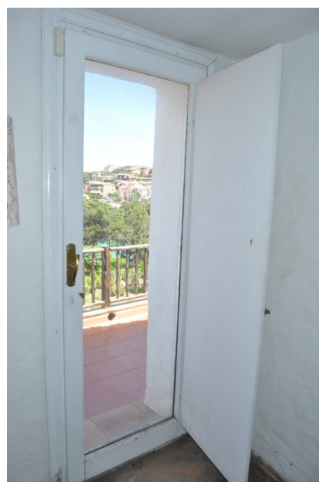
Figg. 41-42-43-44. Vano adibito a deposito
