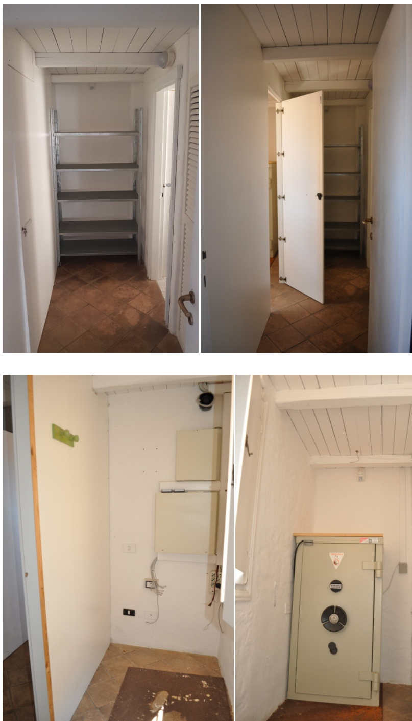
Figg. 25-26- 27-28. Disimpegno e locale di sgombero in cui è ubicata la cassaforte con parete divisoria in pannello multistrato.
