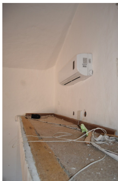
Figg. 21-22-23-24. Vista del piano soppalco
