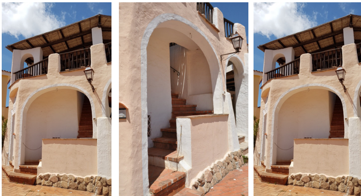
Figg.4-5-6. Foto degli esterni - Prospetto Est di accesso all'immobile
