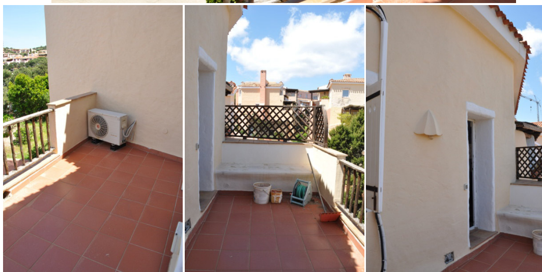
Figg. 45-46-47-48-49. Terrazzo ubicato a Nord-Ovest di pertinenza del locale deposito
