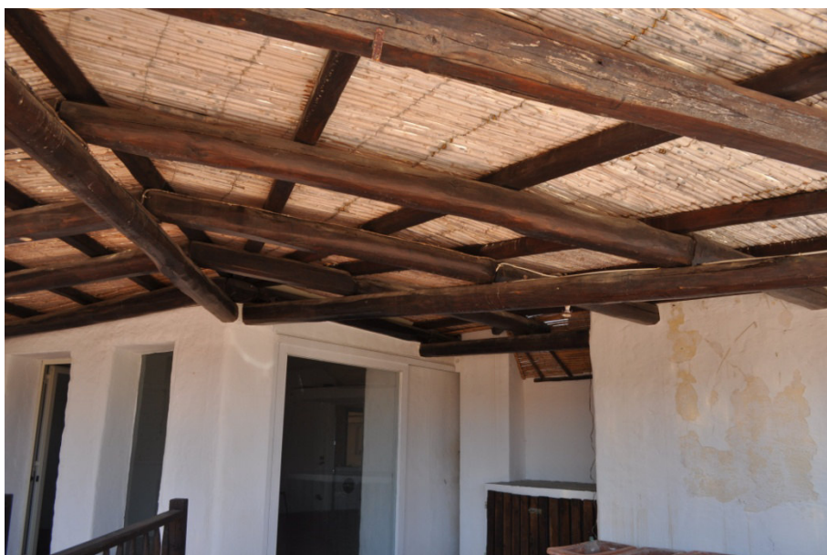
Figg.11-12. La terrazza di pertinenza con dettaglio della copertura
