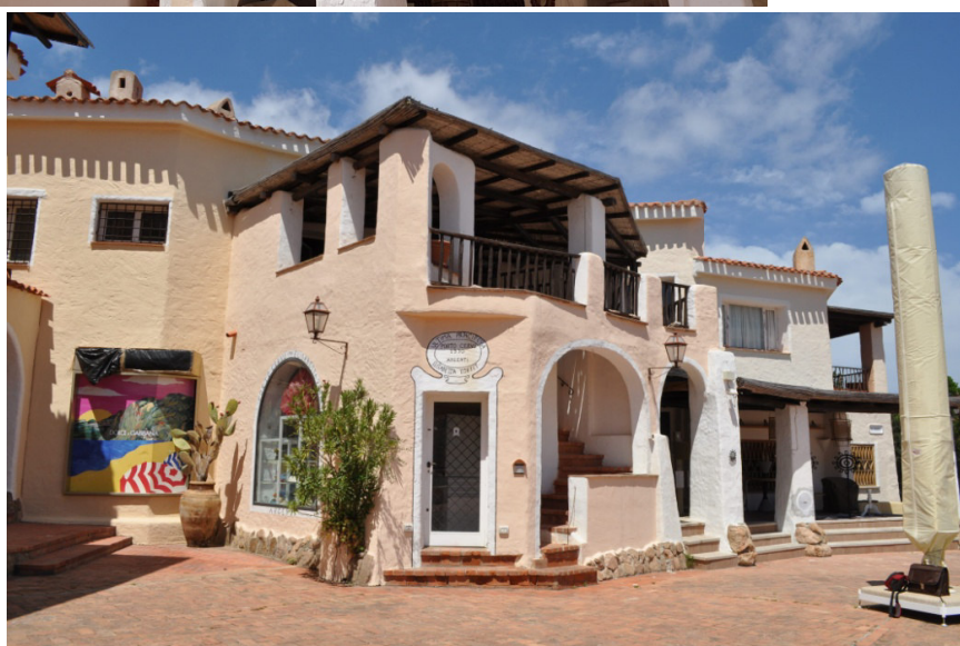
Figg.1-2-3. Foto degli esterni - Prospetto Est di accesso all'immobile
