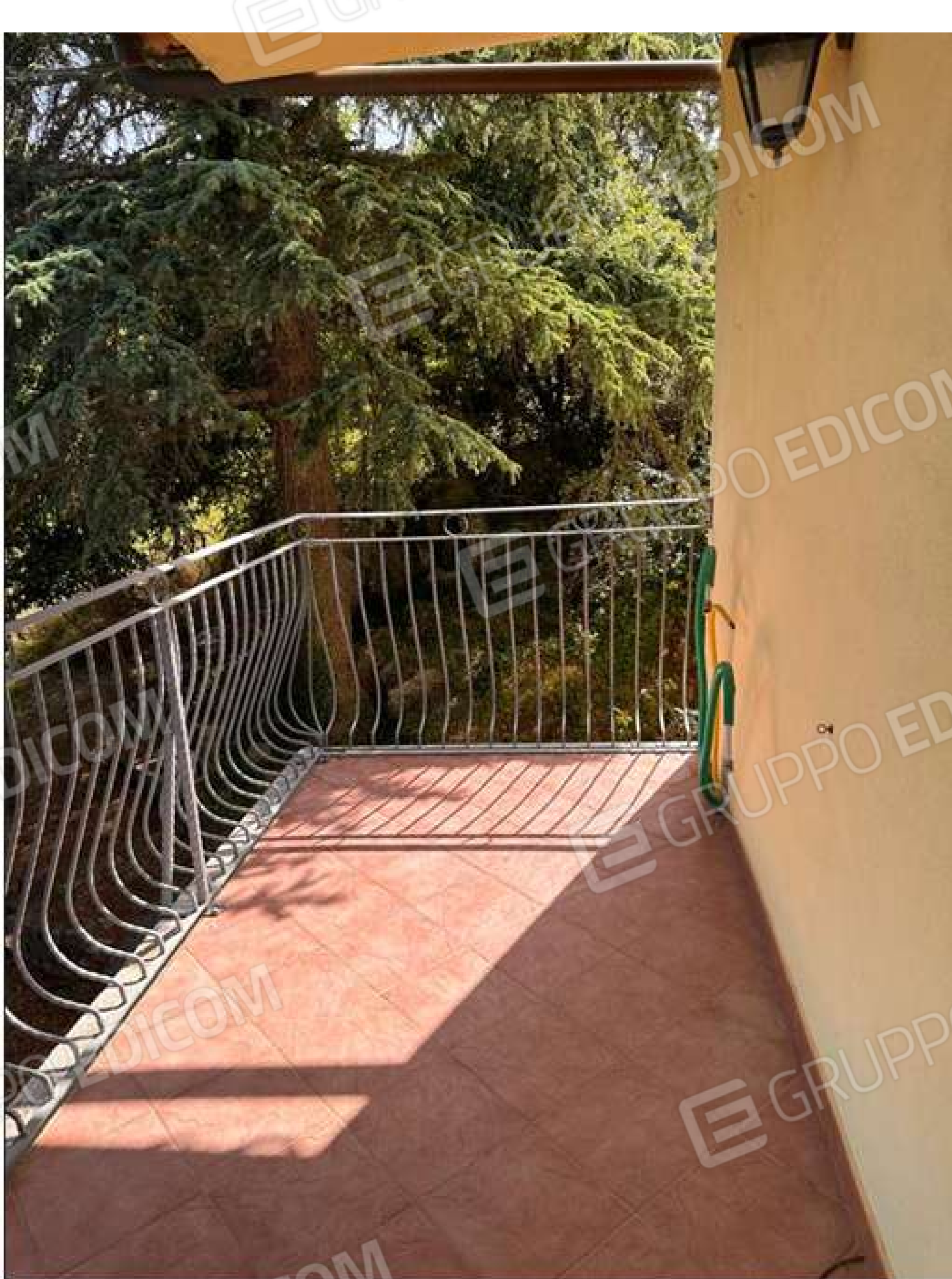
Foto 15: Balconata lato nord
