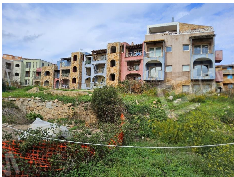
Prospetto frontale intero fabbricato
