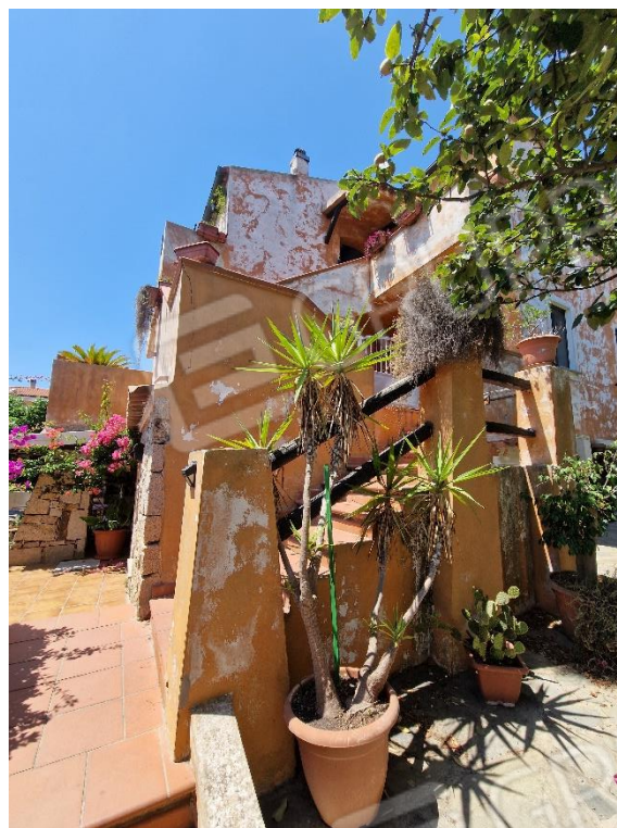
Scala di collegamento ai sub 5 e 6 (ex 3)
