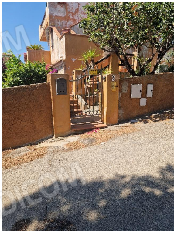
Via Evero Niccolini, cancello di accesso all'immobile attraverso altra proprietà
