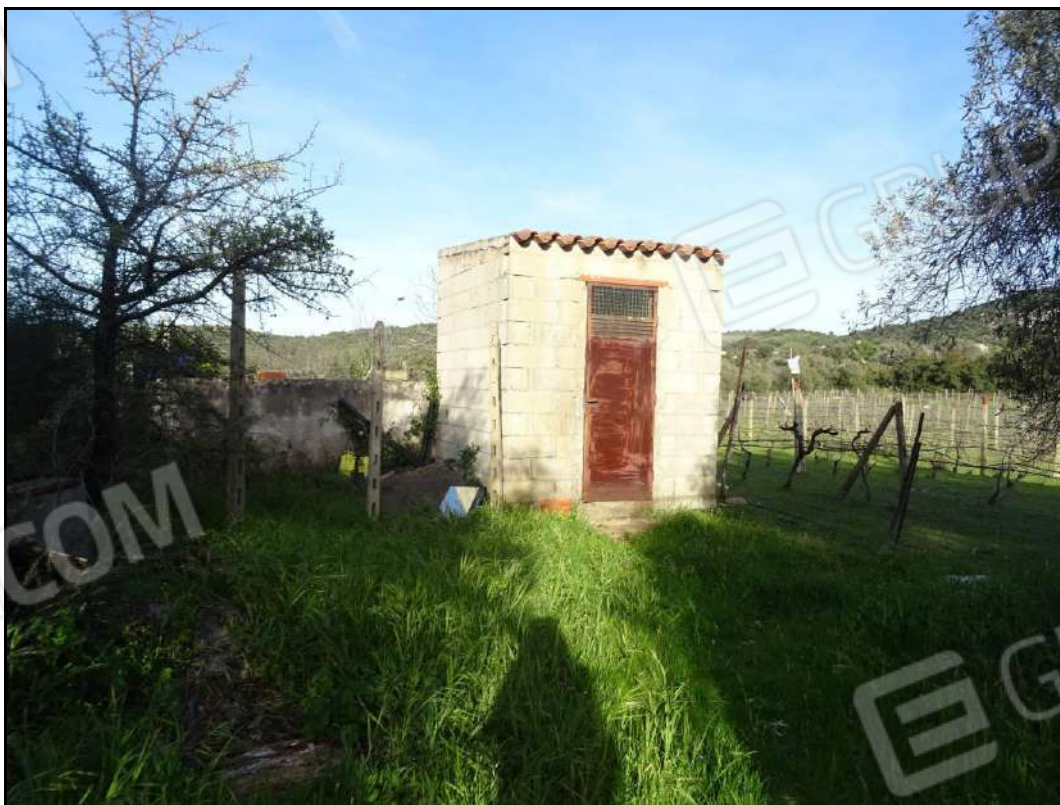
Vista locale tecnico
