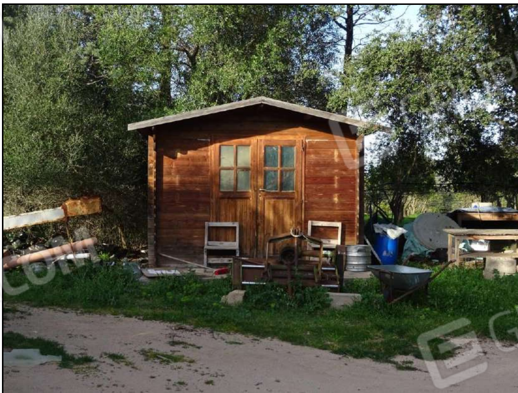
Vista immobile prefabbricato in legno
