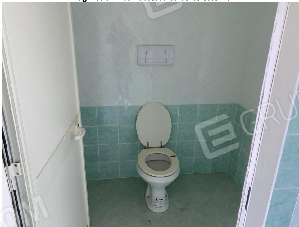
Bagni sub 12 con accesso da corte esterna
