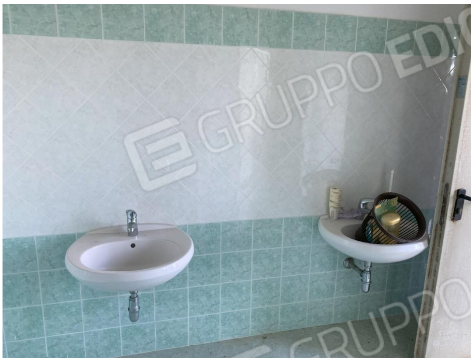
Bagni sub 12 con accesso da corte esterna
