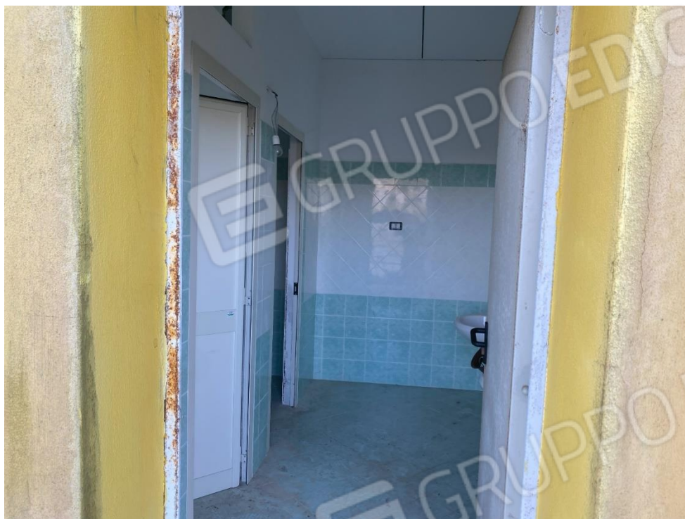
Bagni sub 12 con accesso da corte esterna
