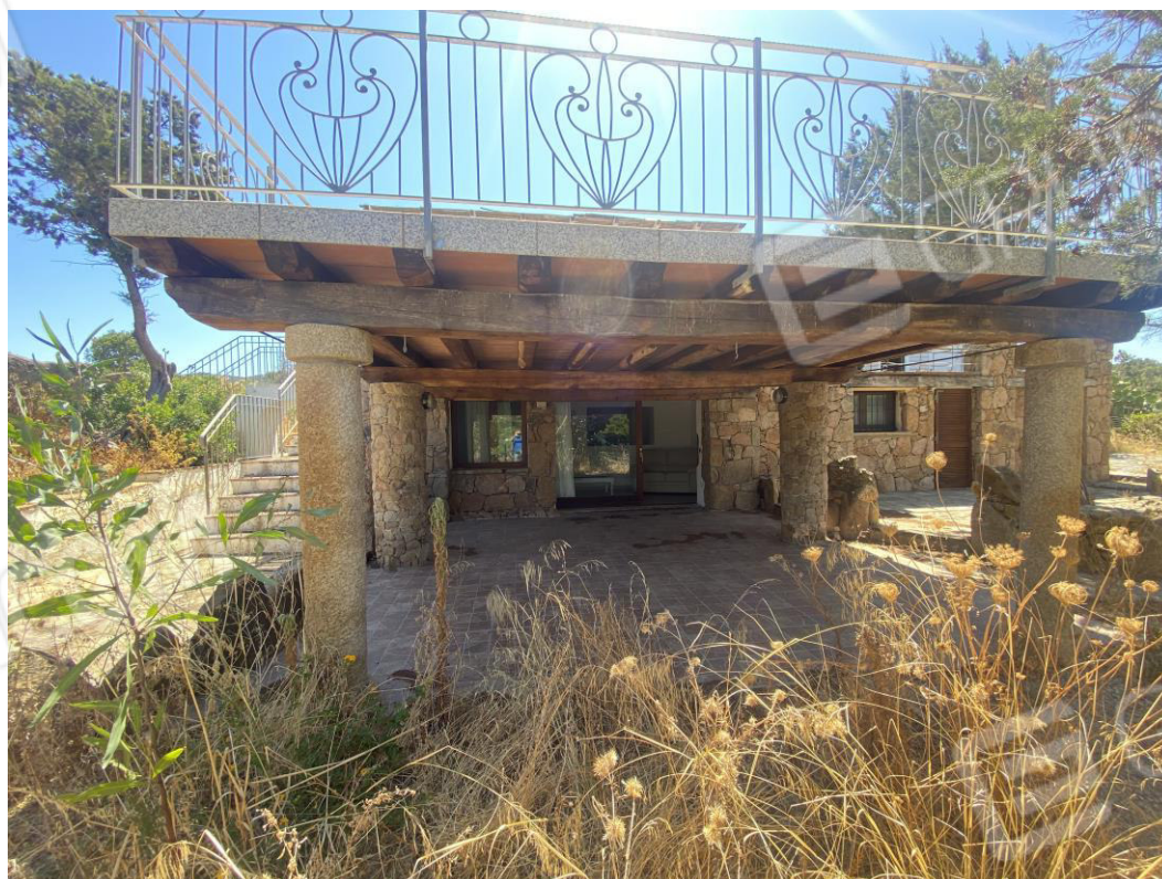
FOTO (12) prospetto Ovest
