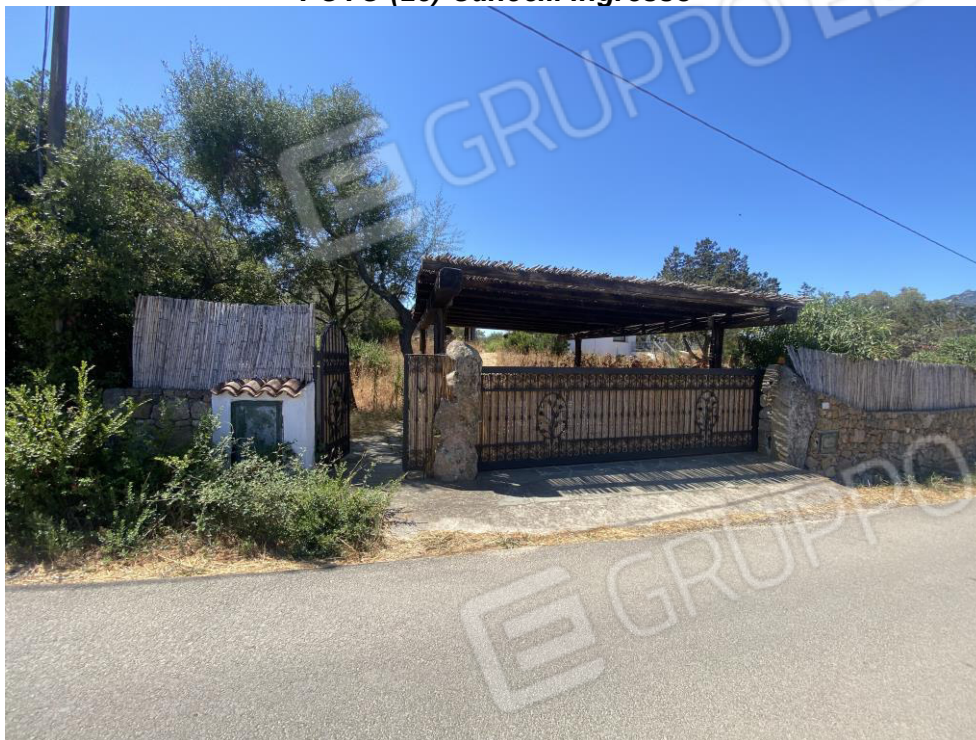
FOTO (23) Cancelli ingresso
