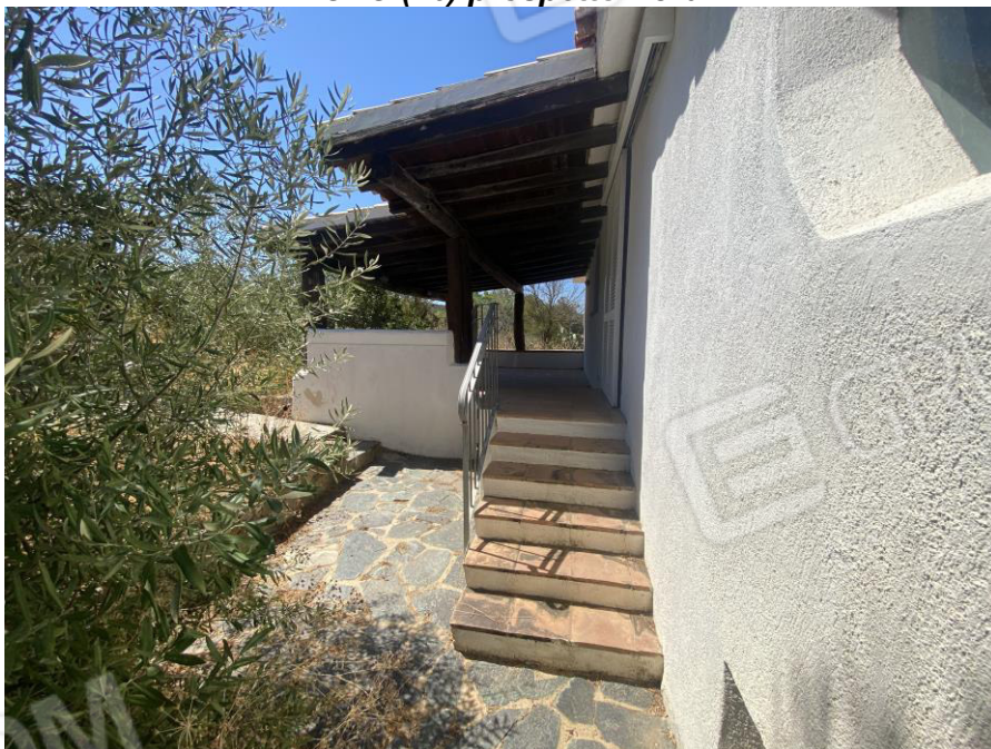
FOTO (16) prospetto Nord
