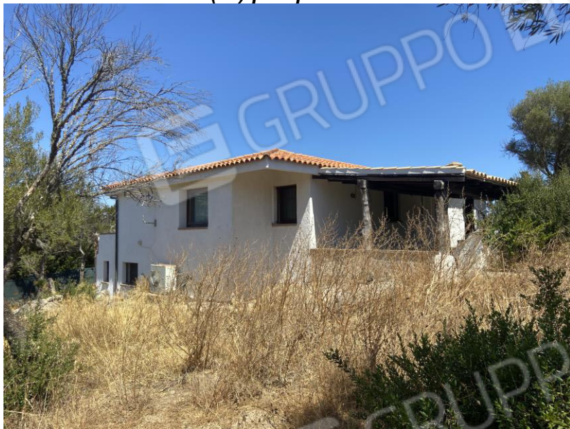
FOTO (15) prospetto Sud-Est
