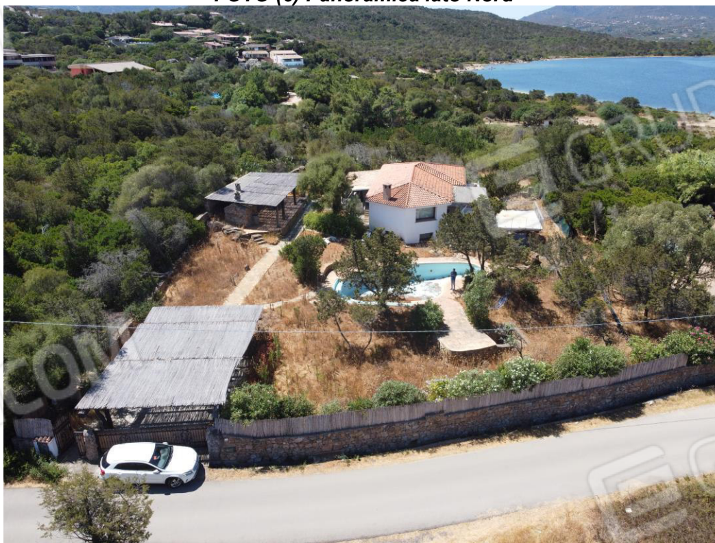
FOTO (6) Panoramica lato Nord
