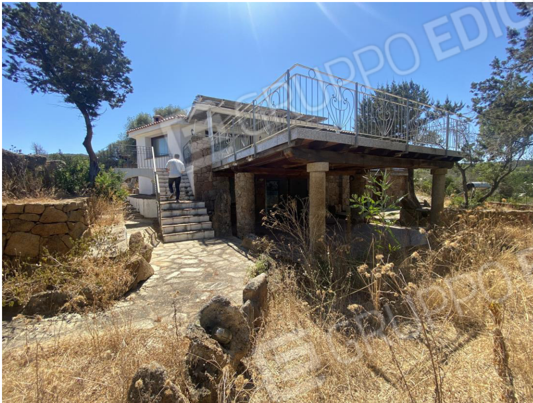
FOTO (11) prospetto Ovest
