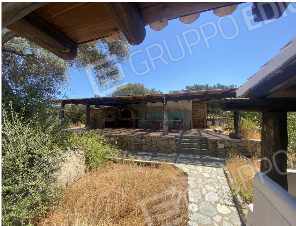
FOTO (17) prospetto Ovest
