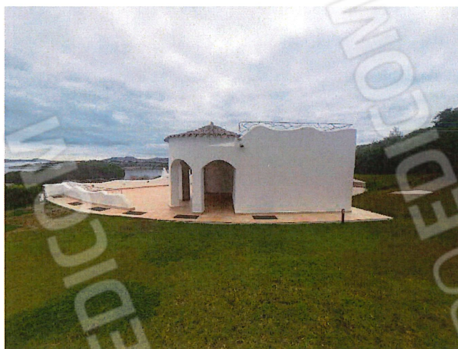
FOTO ESTERNO PIANO PRIMO
