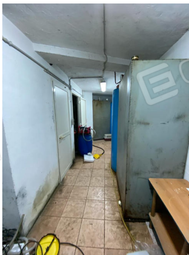
Foto n°44 vano corridoio del magazzino
