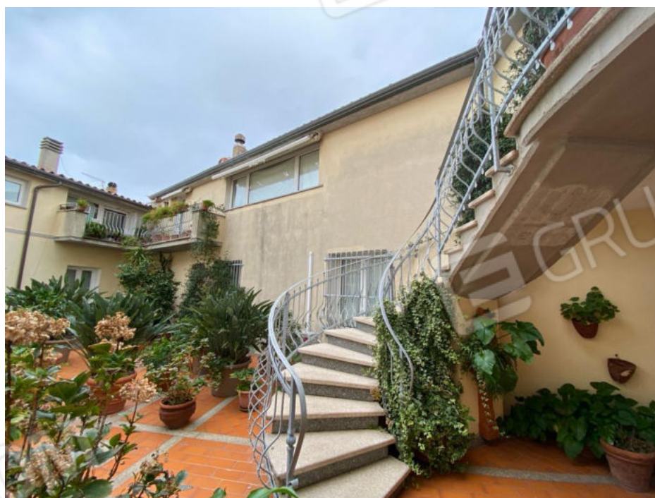
Foto n° 8 particolare scala d'accesso al piano primo dell'immobile identificato al sub.8
