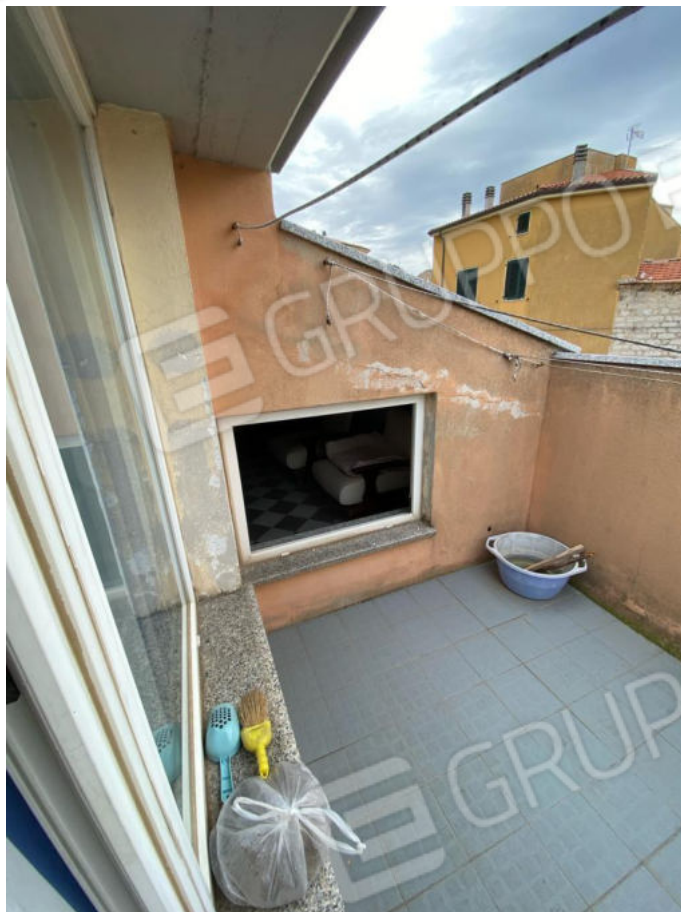
Foto n°16 particolare terrazza calpestabile del piano soffitta
