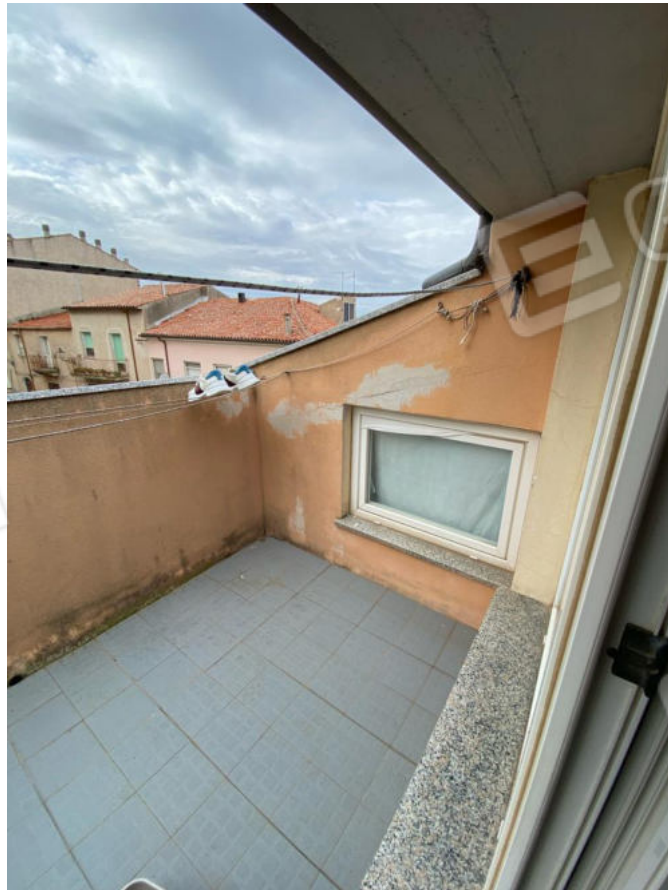
Foto n°17 particolare terrazza calpestabile del piano soffitta
