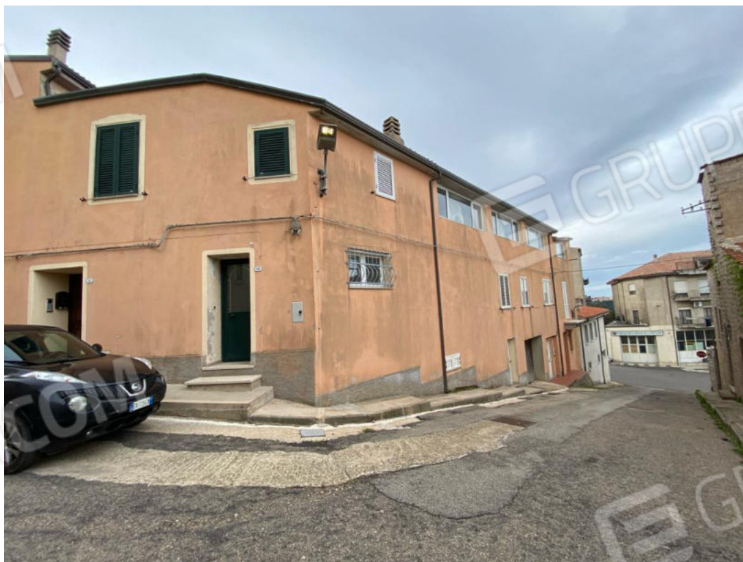
Foto n°2 prospetto Via Corsica lato nord-est
