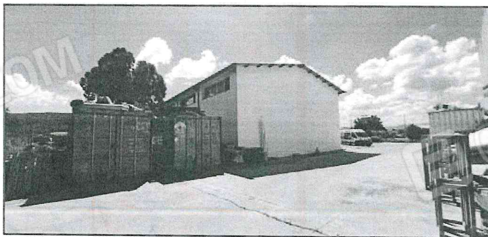
FOTO 36 CAPANNONE PICCOLO VISTA LATO OVEST
