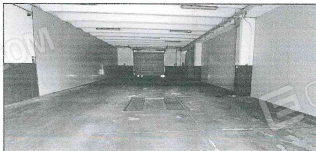
FOTO 24 INTERNO OFFICINA VUOTA SOPRALLUOGO DEL 12/11/2020
