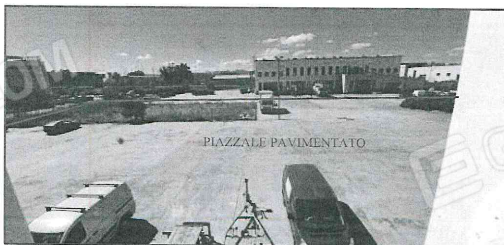
FOTO 48 PIAZZALE PAVIMENTATO E LIMITE LOTTO A SUD
