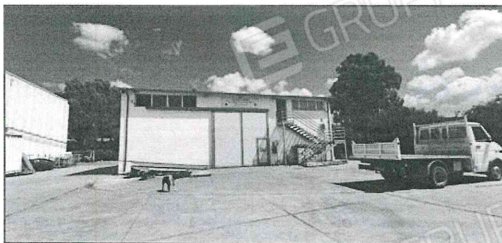
FOTO 35 CAPANNONE PICCOLO VISTA LATO SUD
