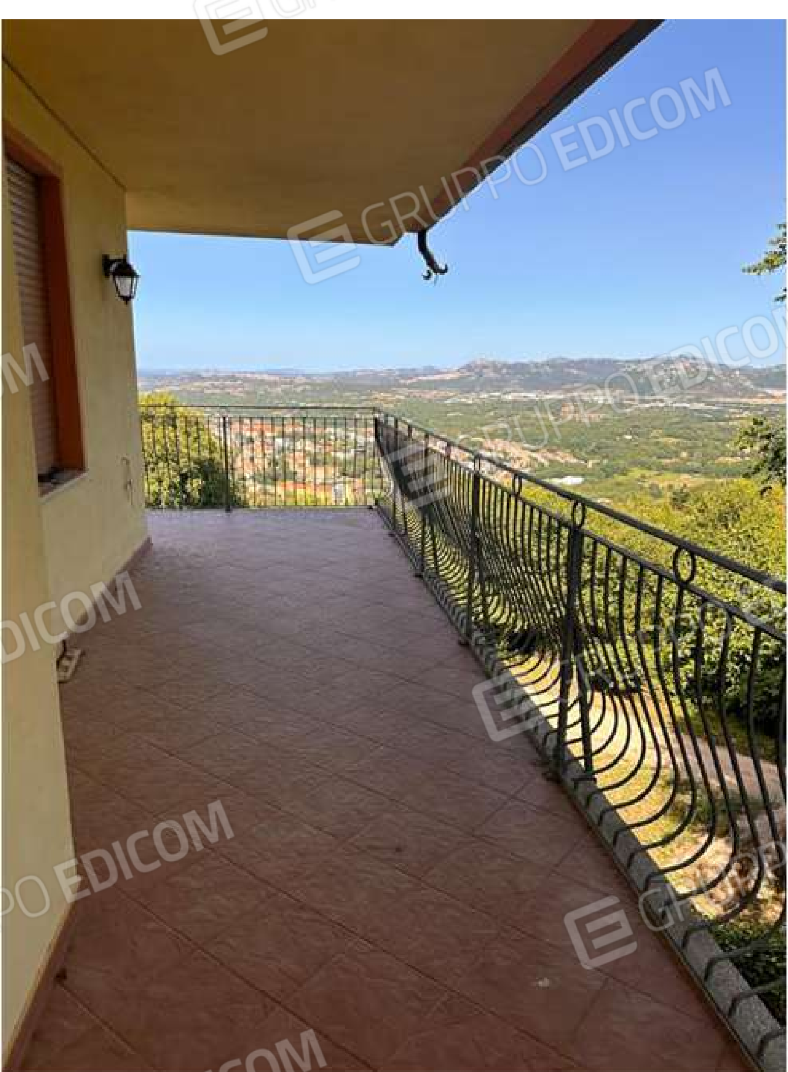
Foto 16: Intera balconata lato nord
