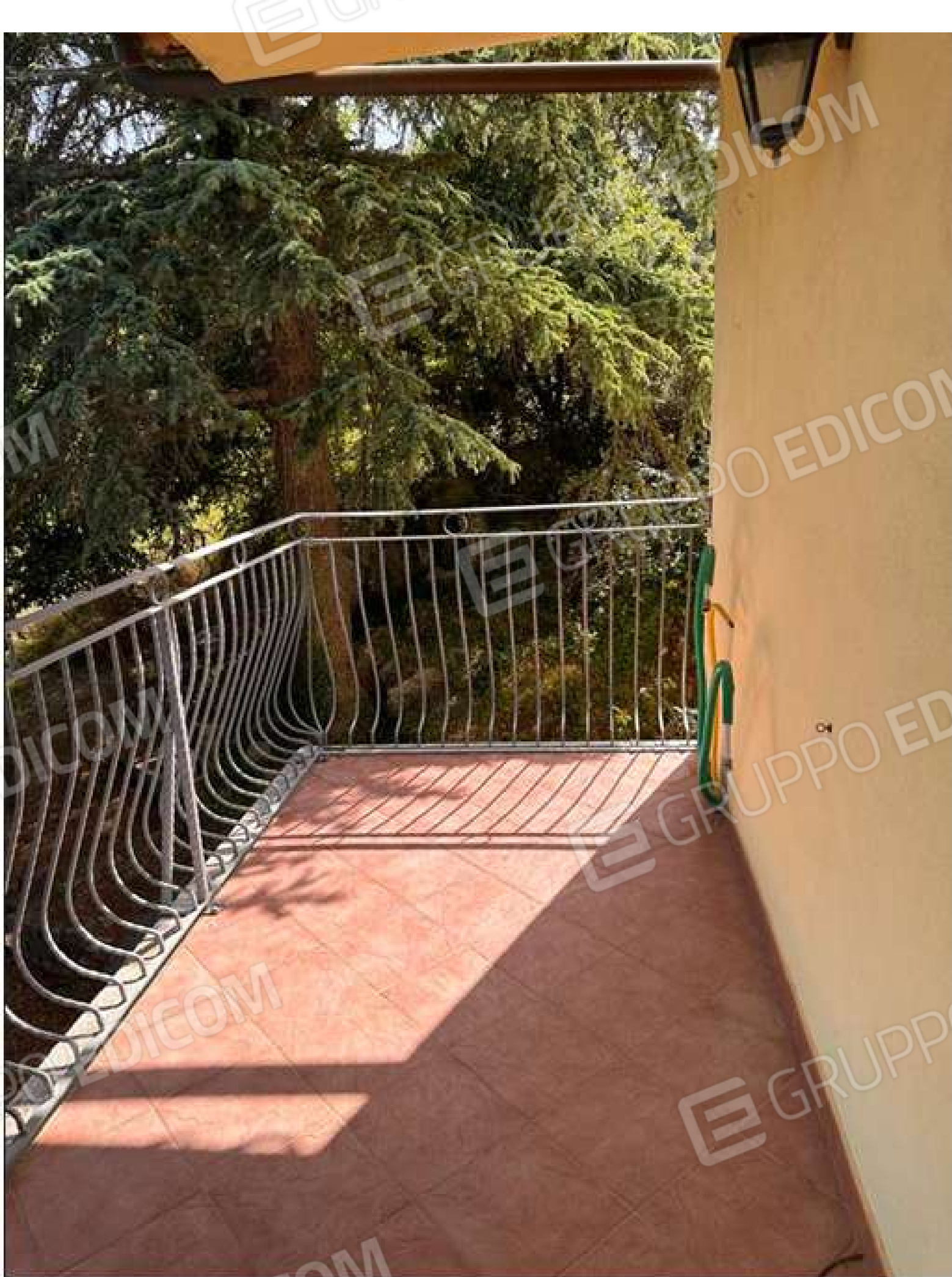
Foto 15: Balconata lato nord
