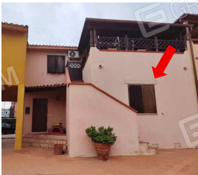
Foto n° 15 – Finestra camera di cui foto 11
