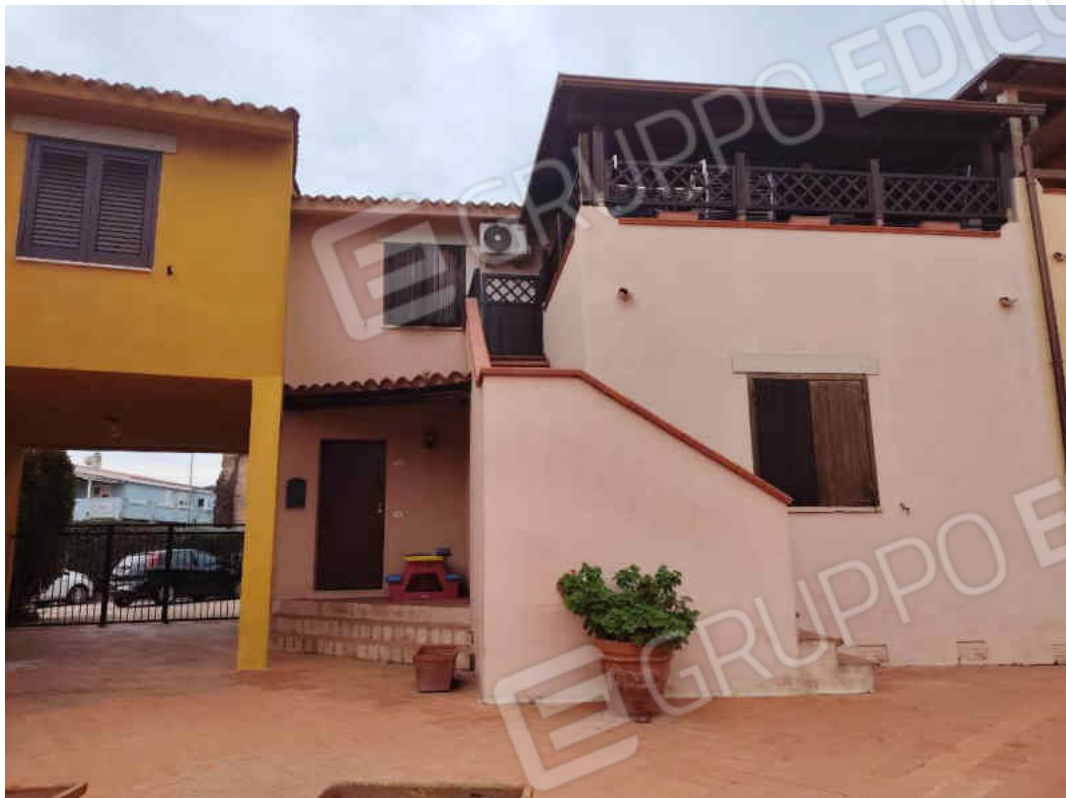
Foto n° 4 – Vista Prospetto principale portone ingresso
