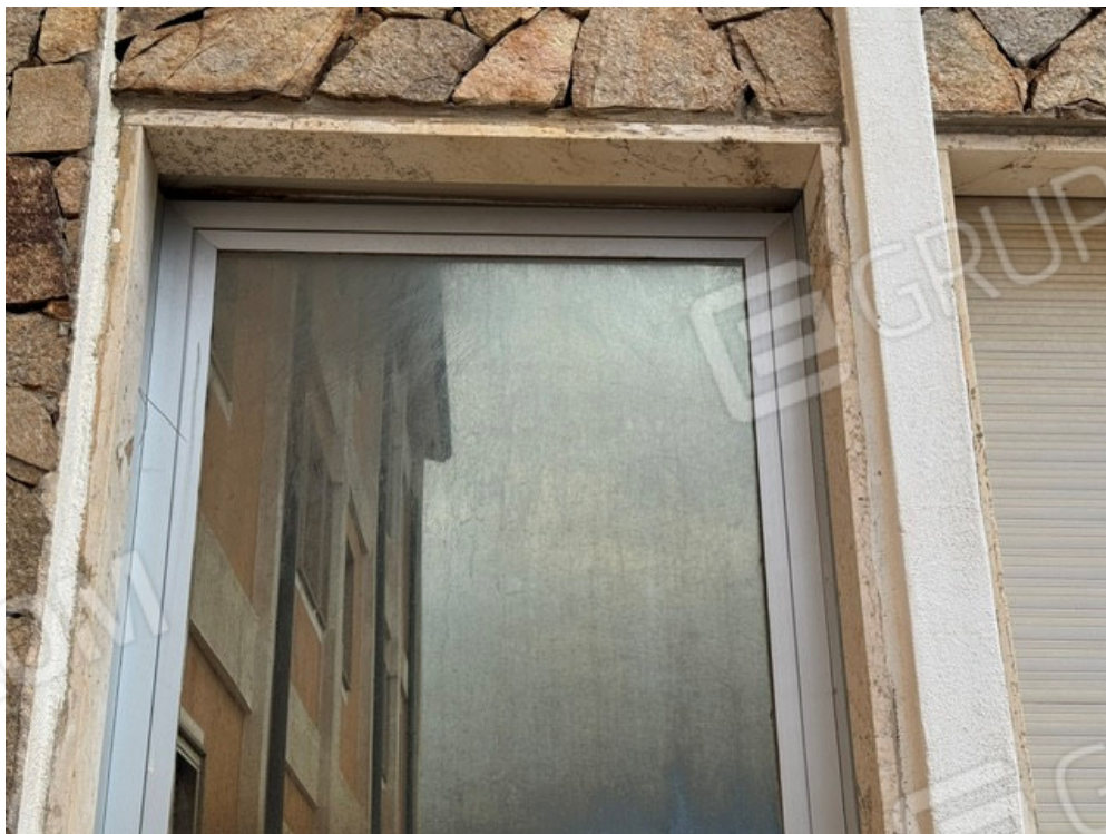
Vista finestra lato corte condominiale
