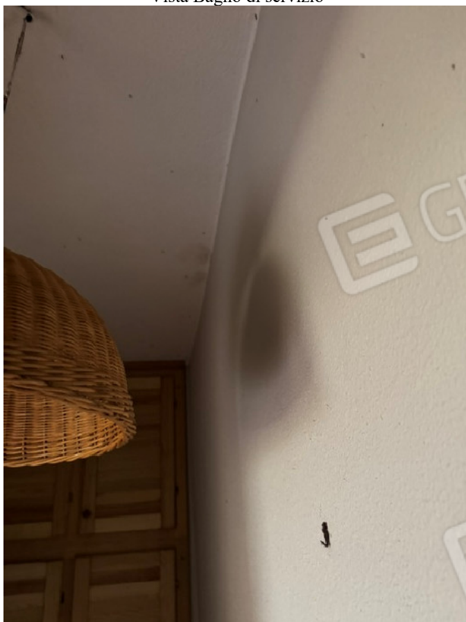
Vista murature disimpegno
