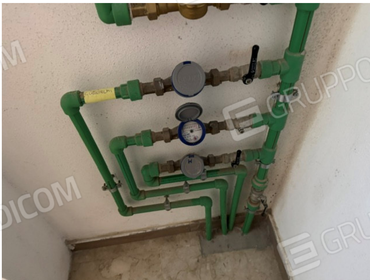
Vista Rastrelliera con contatore acqua sigillato
