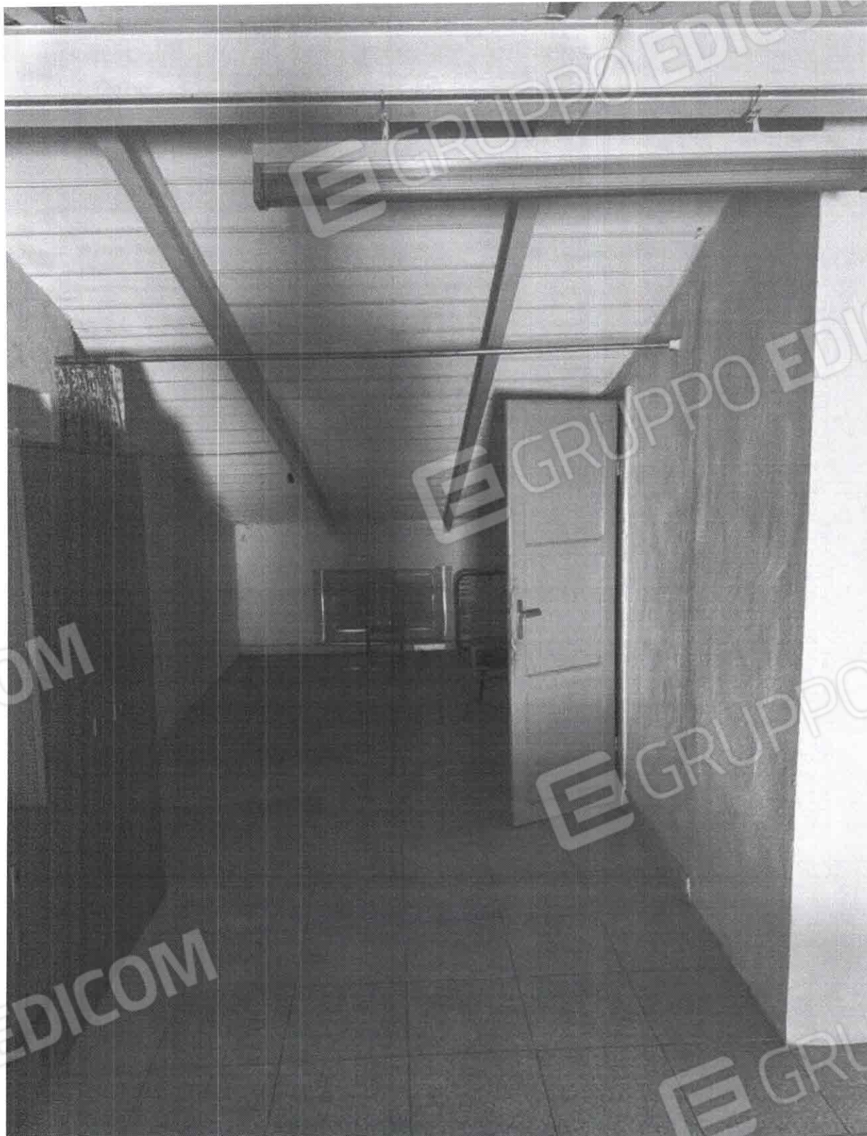
Foto 21: Altra foto del Sottotetto con solaio in legno a due falde e finestrella lato sud
