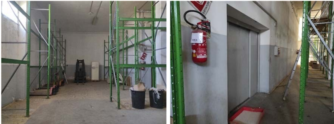
Figura 7 – Vista intera del piano terra (sub 20)
