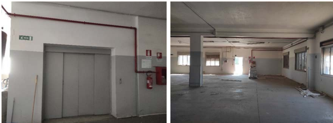
Figura 13 – Vista intera del piano primo (sub 21)
