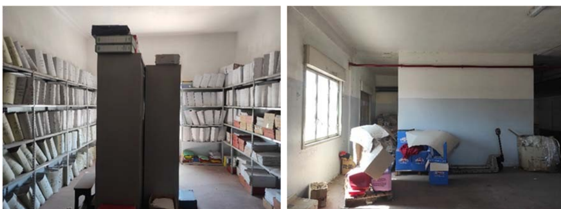
Figura 15 – Vista intera del piano primo (sub 21)
