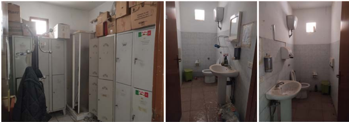
Figura 11 – Vista intera del piano terra (sub 20)
