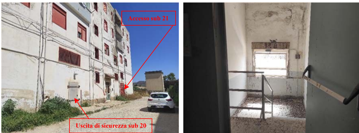
Figura 12 – Vista prospetto Sud-Ovest. A dz vano scala del sub 21
