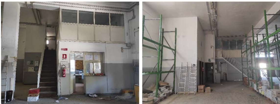
Figura 6 – Vista intera del piano terra (sub 20)
