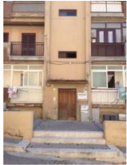
Foto 2 – ingresso e prospetto del bene visto da Nord
