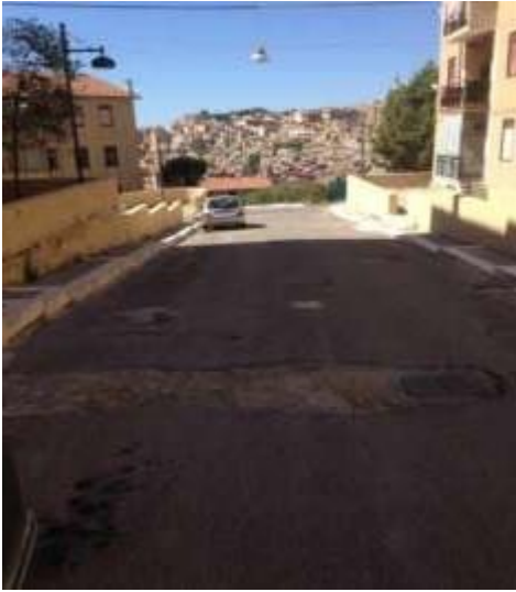
Foto 1 via P. Geremi ingresso palazzina B
