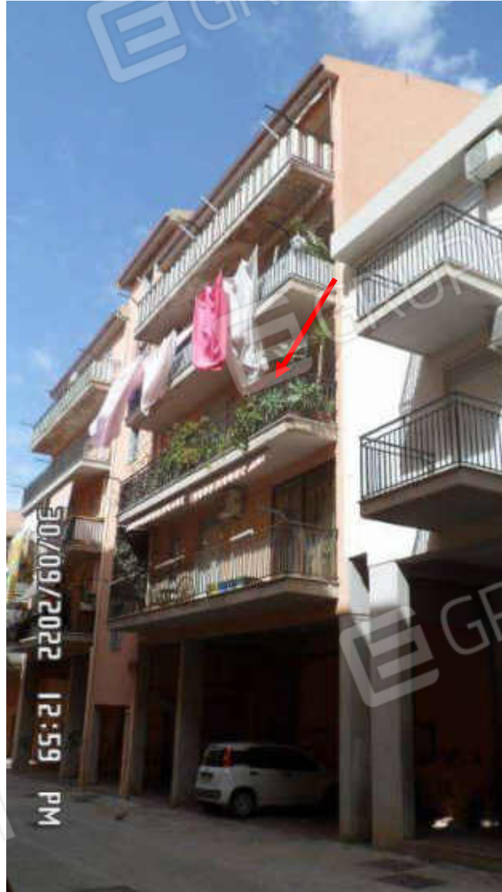
FOTO 4 - VEDUTA DELL'APPARTAMENTO DALLA VIA MARINUZZI
