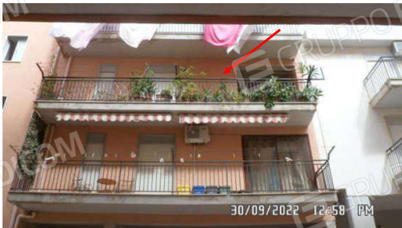
FOTO 3 - VEDUTA DELL'APPARTAMENTO DALLA VIA MARINUZZI
