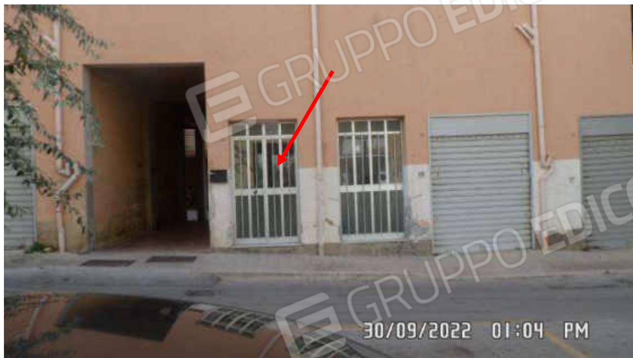
FOTO 2 - VEDUTA SU VIA NOVELLI DEL PORTONE D' INGRESSO DELLA SCALA AL CIVICO 21
