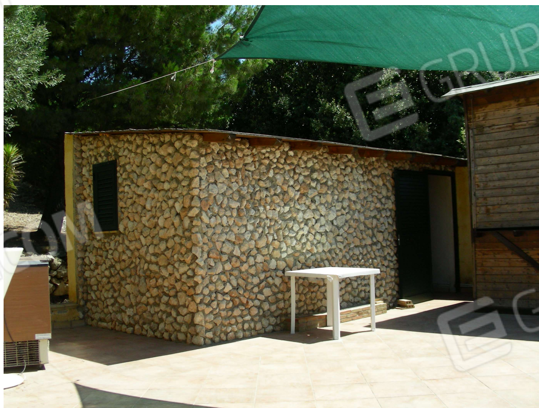
foto n. 12 locale di sgombero
