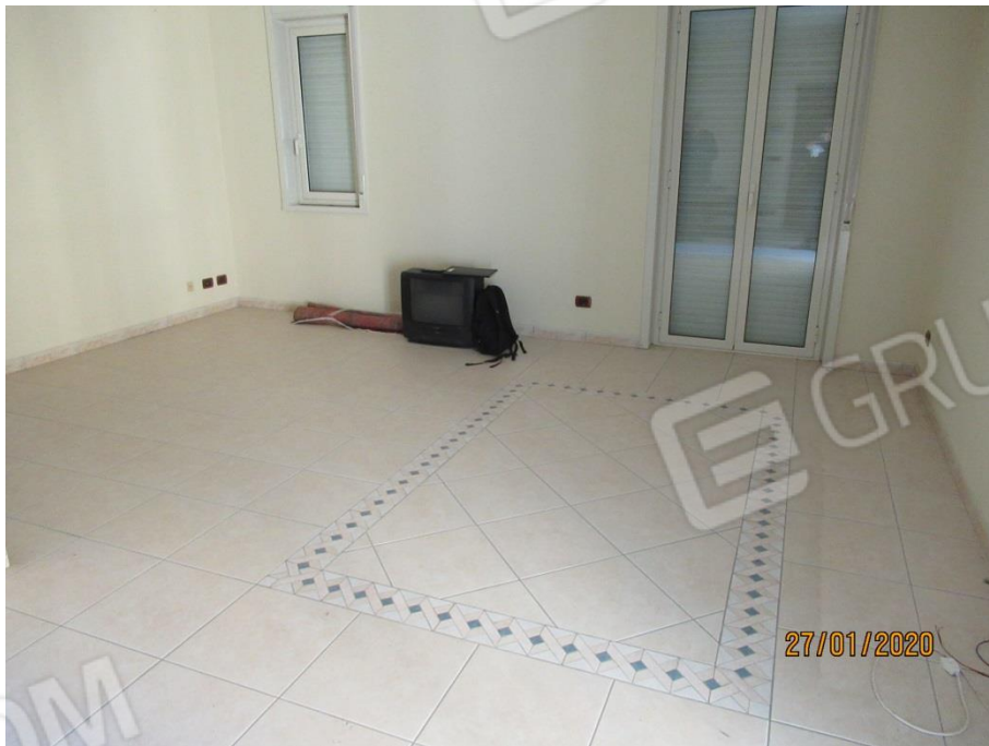
Lotto 01 – fotografie interne (piano terra)
