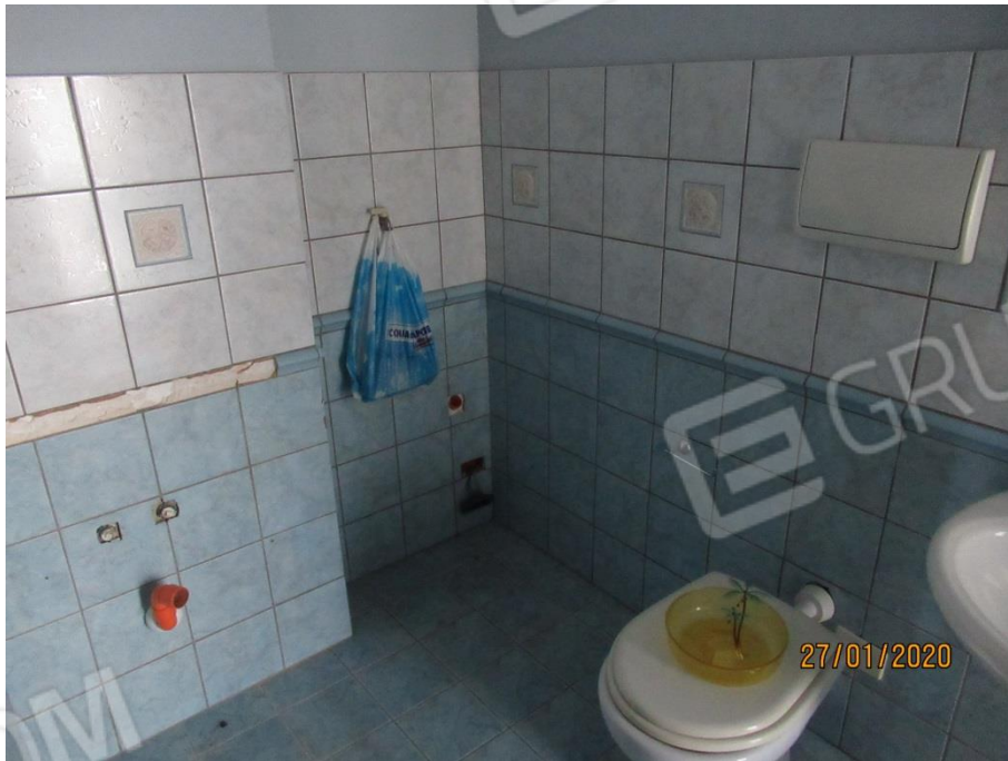
Lotto 01 – fotografie interne (piano terra)
