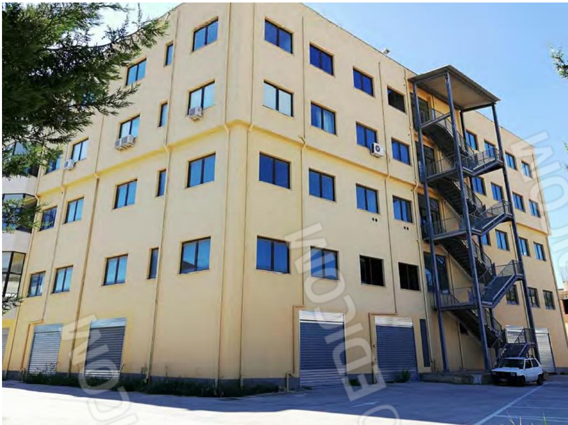
Prospetto posteriore nord-ovest intero fabbricato
