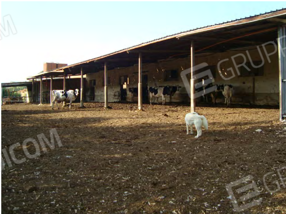
TETTOIA A RIDOSSO DELLA STALLA BOVINI foglio n. 35 particella 169 sub. 2
