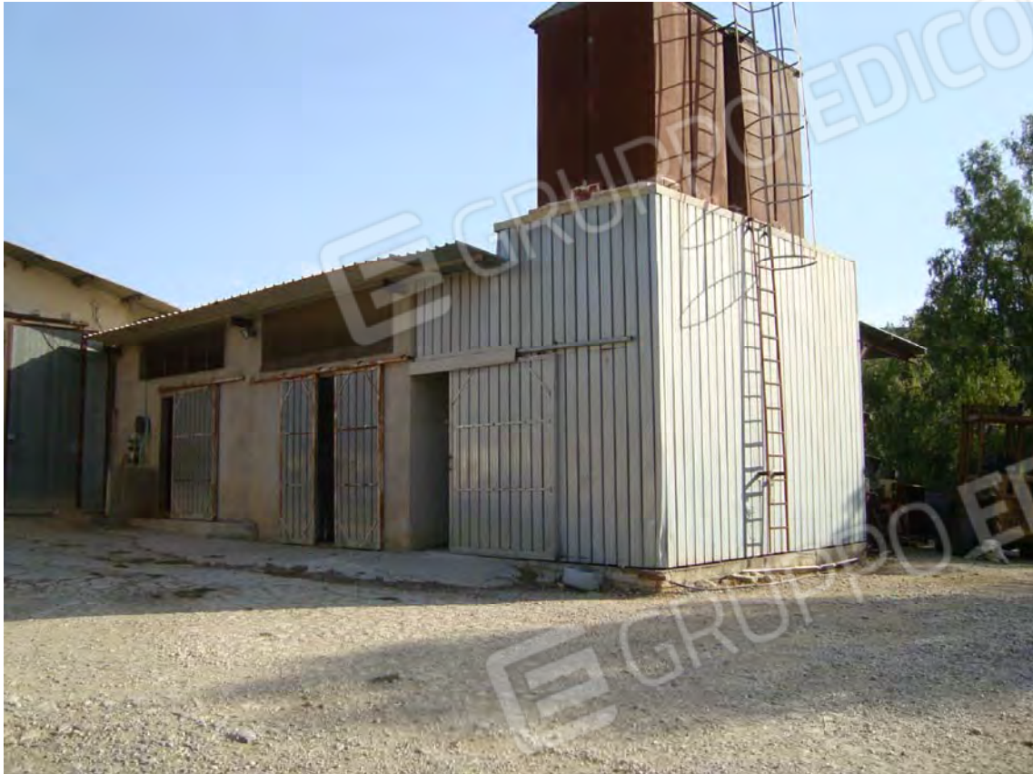
SILOS foglio n. 35 particella 169 sub. 2
