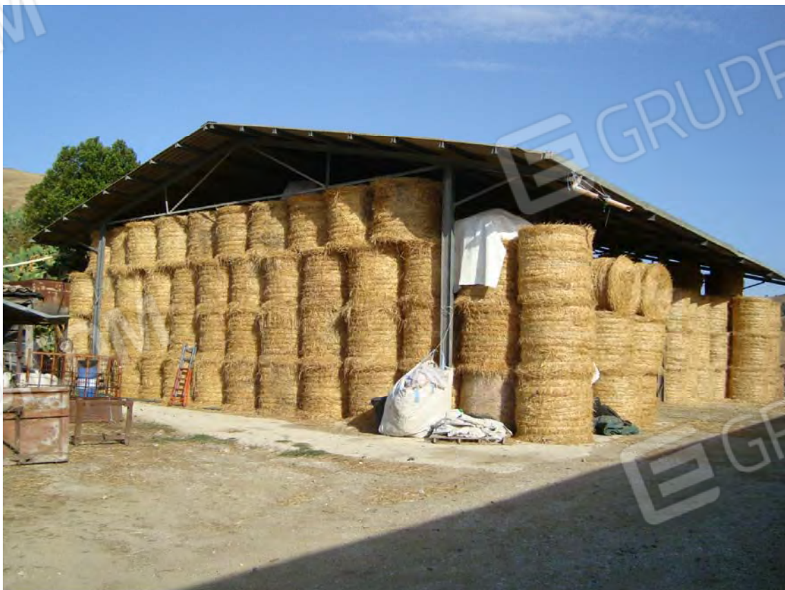
FIENILE foglio n. 35 particella 169 sub. 2
