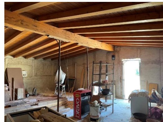
Locale al P.1° (Edificio 1)
