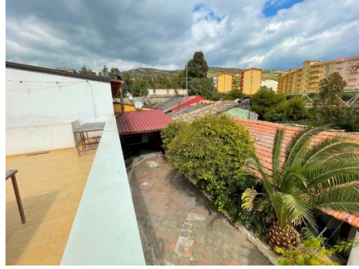
Terrazza, locale a P.1°, tettoia, edificio 3
