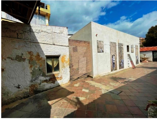
Locali Custode, locali al grezzo, pertinenza
