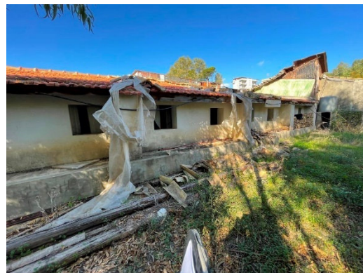
Edificio 3 (Vista da Sud-Est)
