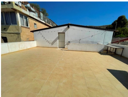
Terrazza e locale al P.1° (Edificio 1)
