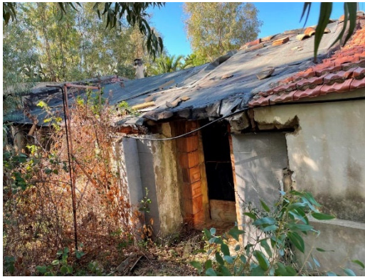
Edificio 3 (Vista da Est)
