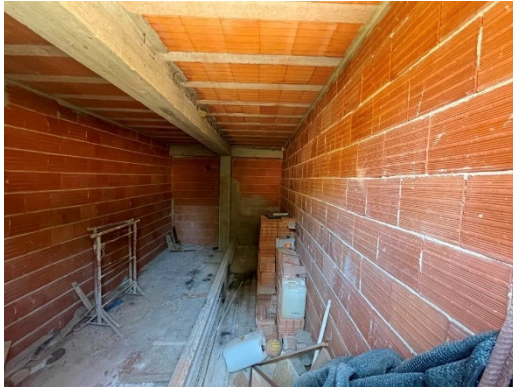
Locali al P.T. (Edificio 1)
