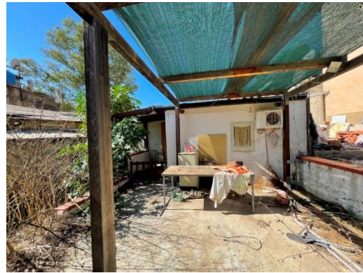
Edificio 4 (Vista da Est)
