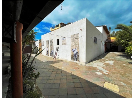
Locali al grezzo, pertinenza
