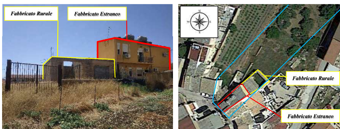
Figure 11 – In celeste il confine della part. 431 (ex 87), in giallo fabbricato rurale dei debitori, in rosso il fabbricato di terzi da estraniare dalla procedura
