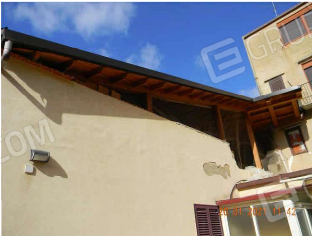
FOTO 10 - Vista della nuova copertura lignea.
