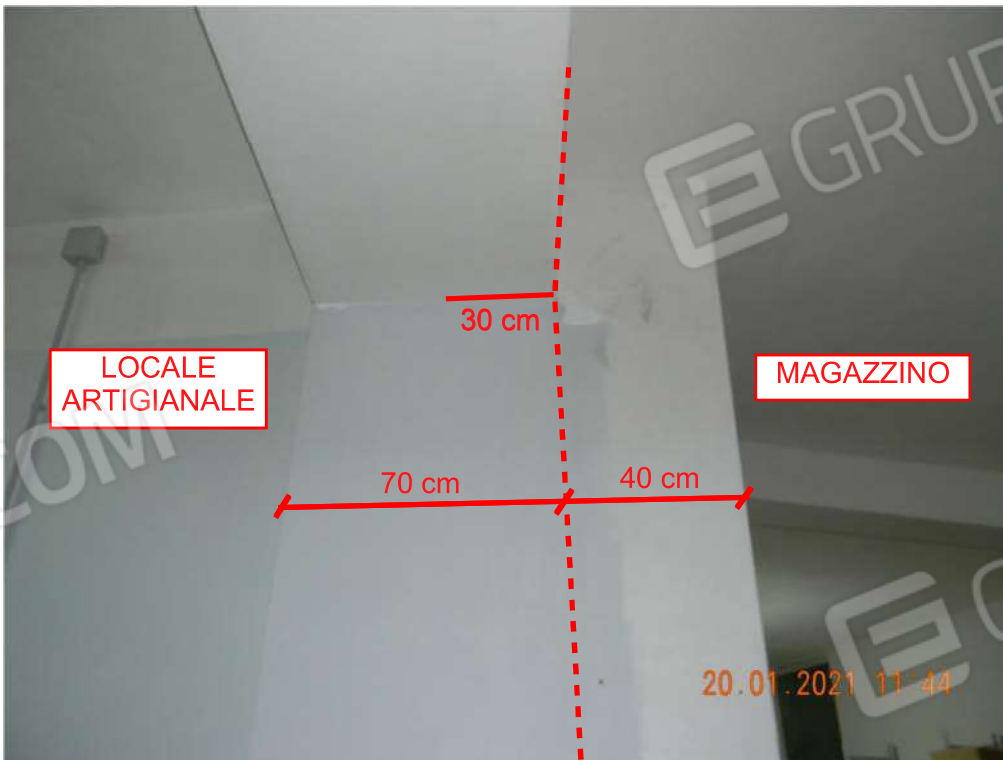
FOTO 08 - Filo (linea tratteggiata) e spessore (30 cm) del muro di separazione da realizzare tra il magazzino ed il locale artigianale.
