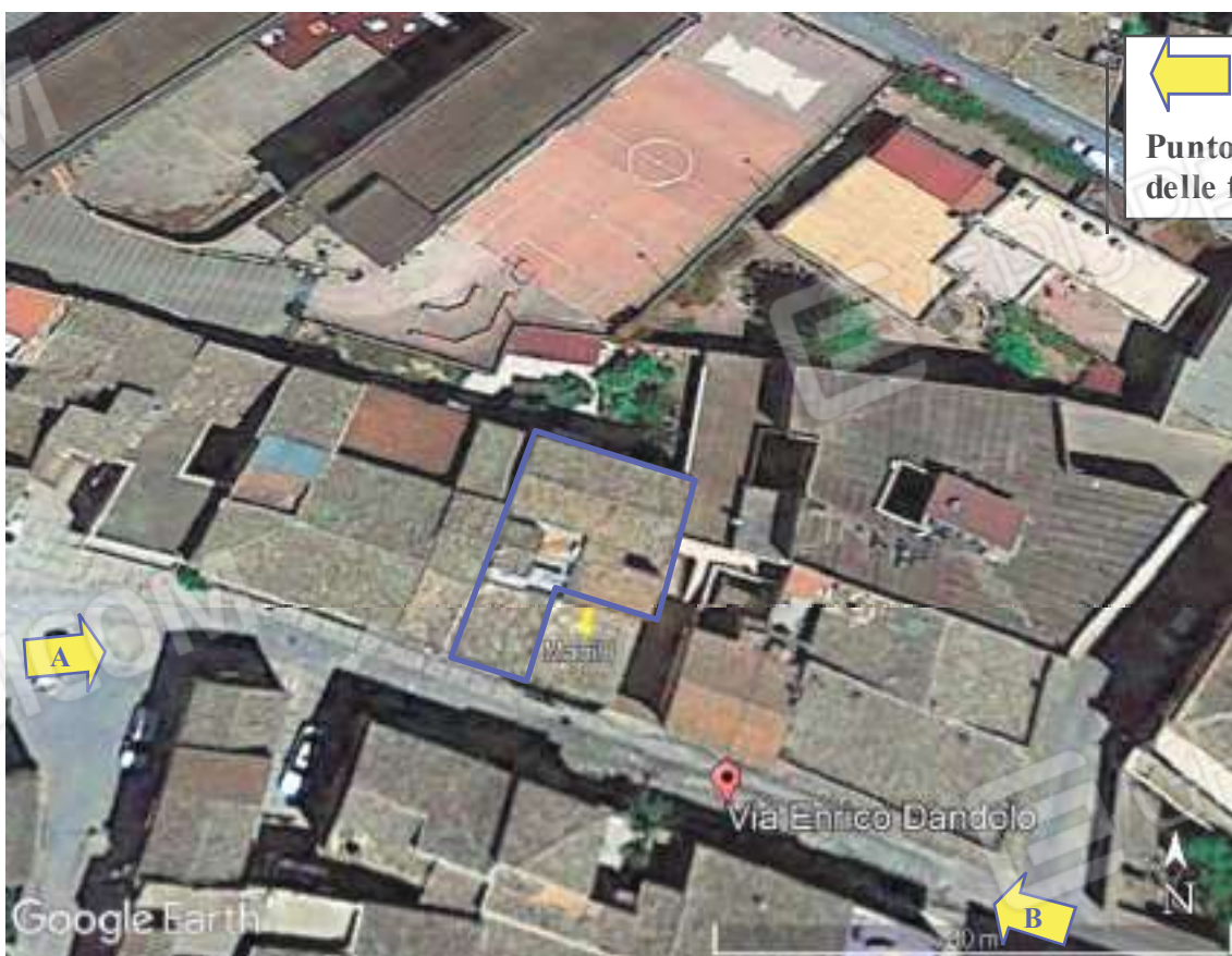
Contesto urbanistico nelle vicinanze della Struttura per Attività Assistenziale di via Dandolo a Canicattì
