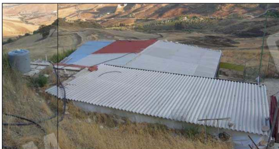
foto 21 (vista dalla strada d'accesso della copertura della pertinenza n. 3)
