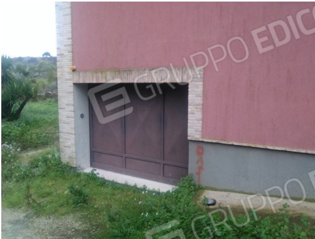
Fotografia J.1 - Accesso su prospetto nord.
