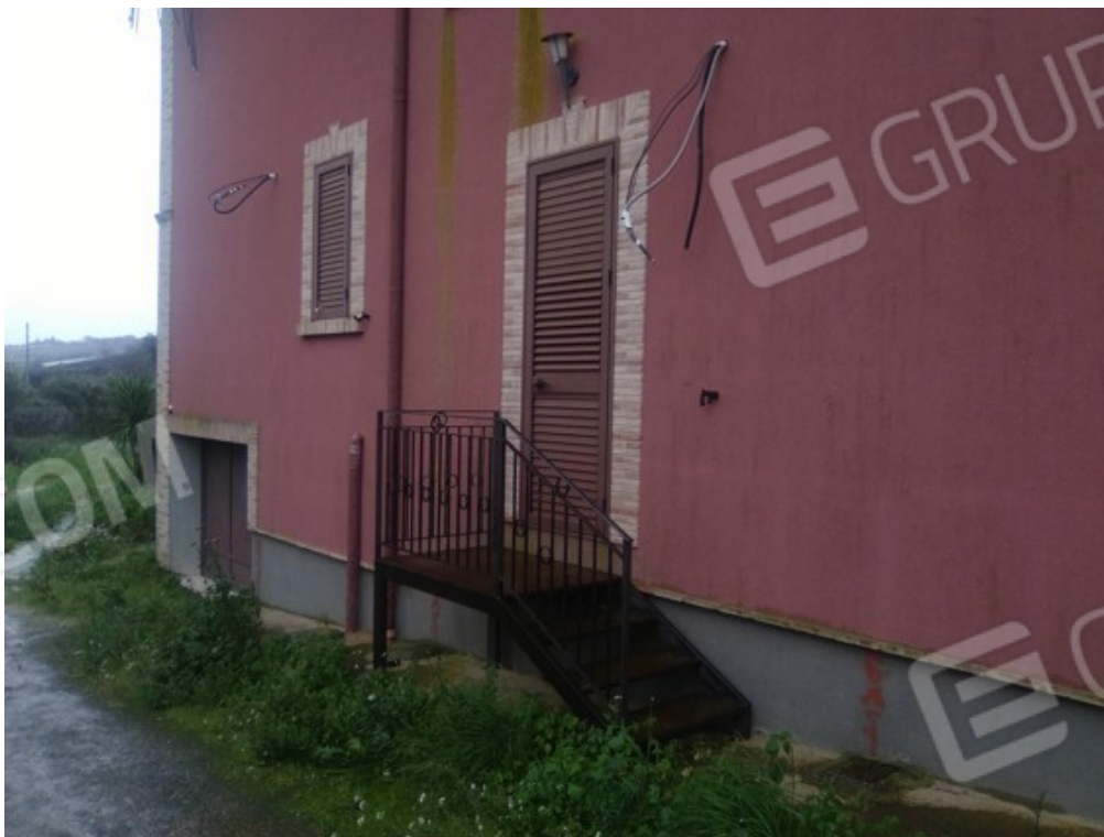
Fotografia J.10 - Accesso secondario su corte comune.
