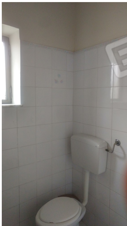
Fotografia I.8 - Ripresa dell'interno locale al civico n. 21 via Portella delle ginestre. Si nota la presenza di un muro che separa il sub in due locali con usi diversi. Servizi igienici.
