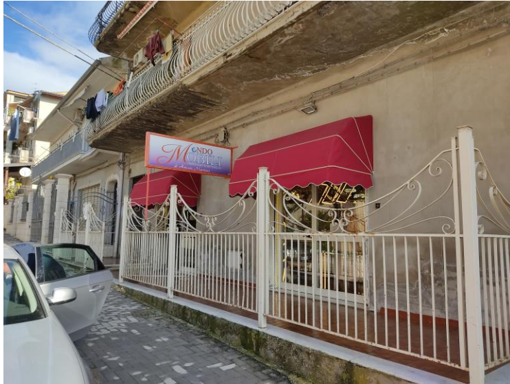
Fig.4 Prospetto su via Trieste
