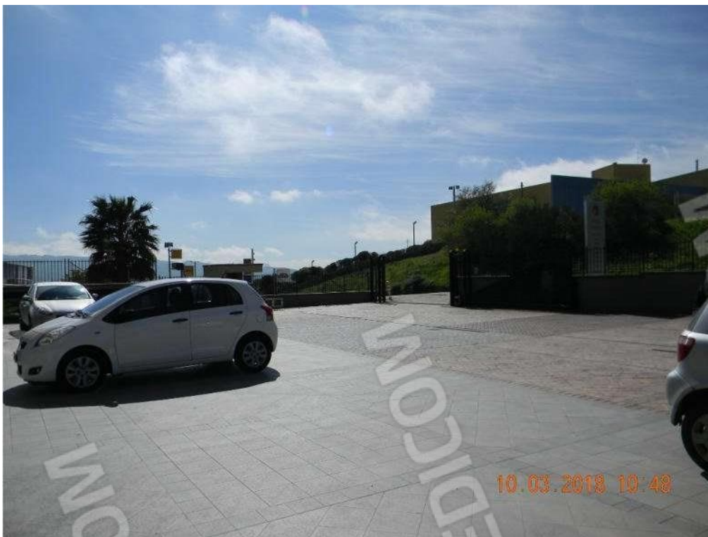
Foto 04 - Vista dell'ampio parcheggio annesso all'immobile commerciale.
