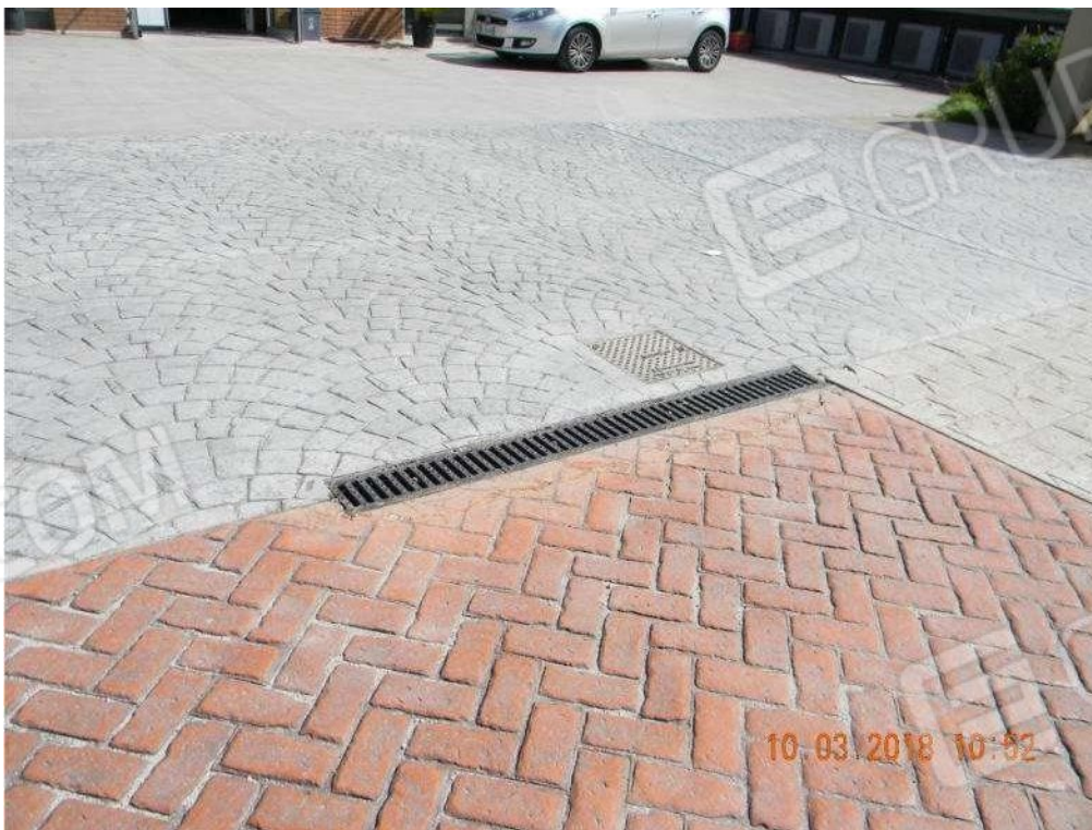
Foto 12 - Particolare della pavimentazione esterna e del sistema di raccolta delle acque piovane.
