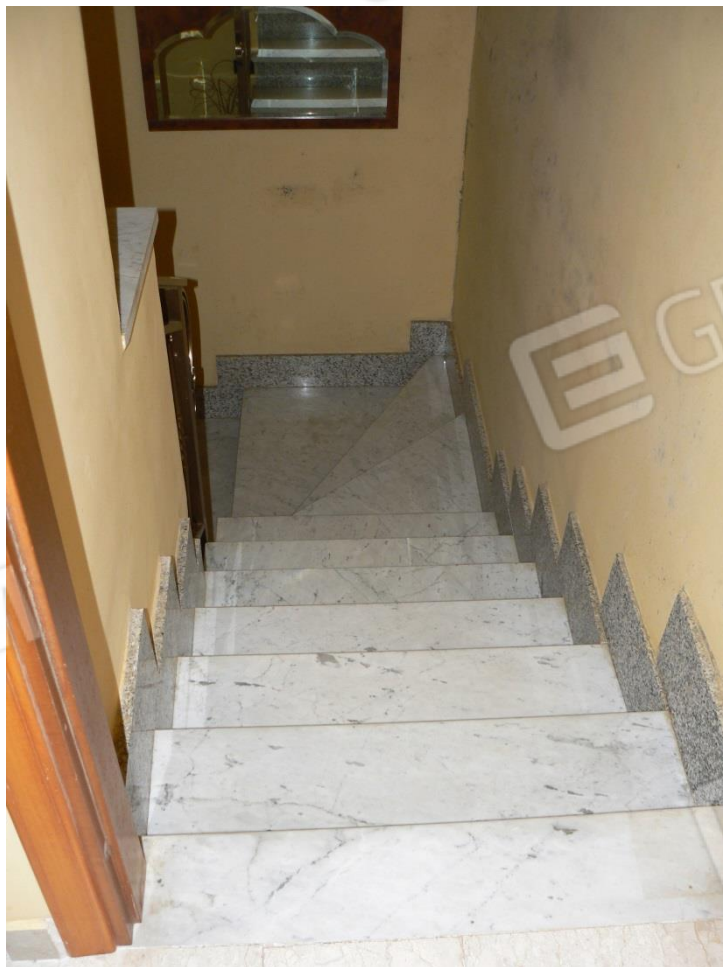
SCALETTA DI ACCESSO AL PIANO SECONDO FOTO N° 26
