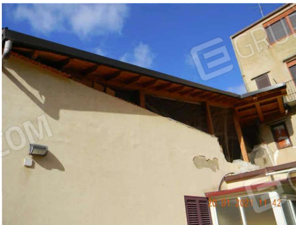
FOTO 10 - Vista della nuova copertura lignea.
