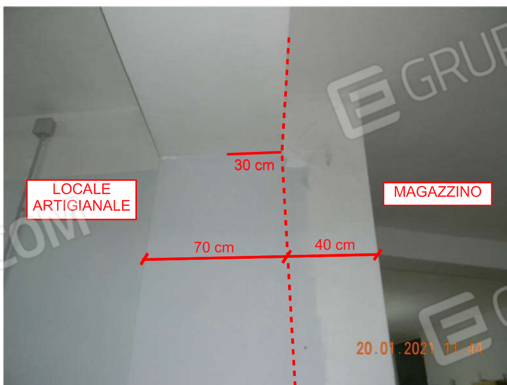
FOTO 08 - Filo (linea tratteggiata) e spessore (30 cm) del muro di separazione da realizzare tra il magazzino ed il locale artigianale.
