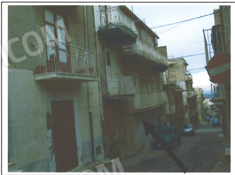
Ingresso da via Di Vincenzo
