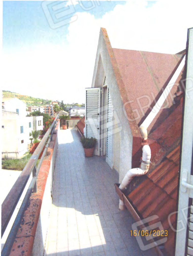
FOTO 20 Veduta dal balcone lato Nord
