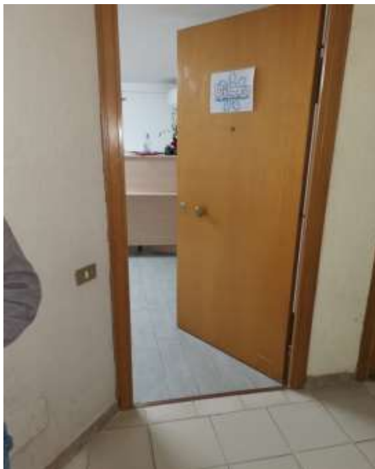
Foto n° 6 Porta di ingresso all'unità
